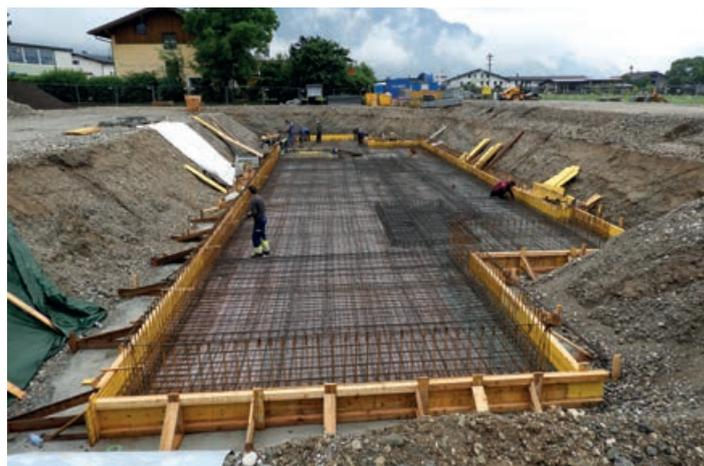
Herstellung der Fundamentplatte.
