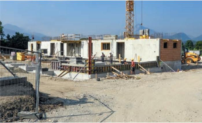
Betonierarbeiten für die Fundamente der Fahrzeughalle.
