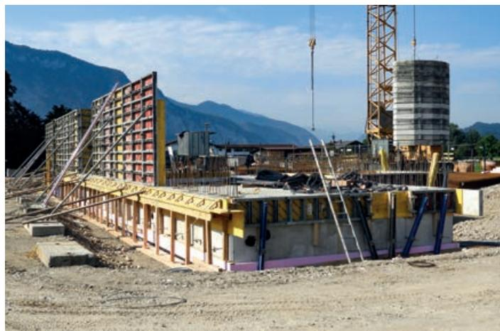
Betonierarbeiten der tragenden Innenwände des Erdgeschoßes.
