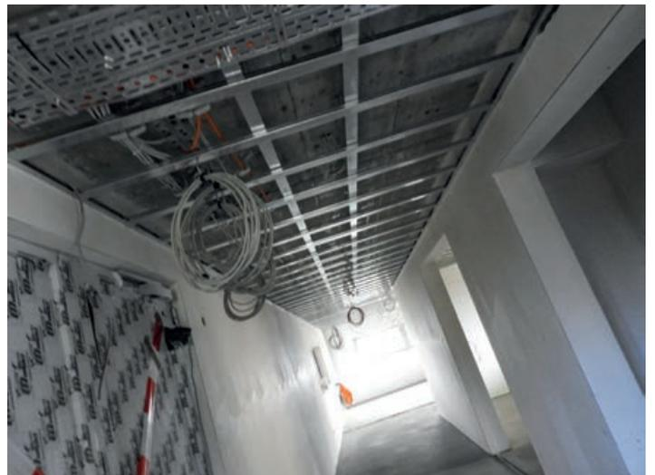
Montage der Deckenunterkonstruktion.
