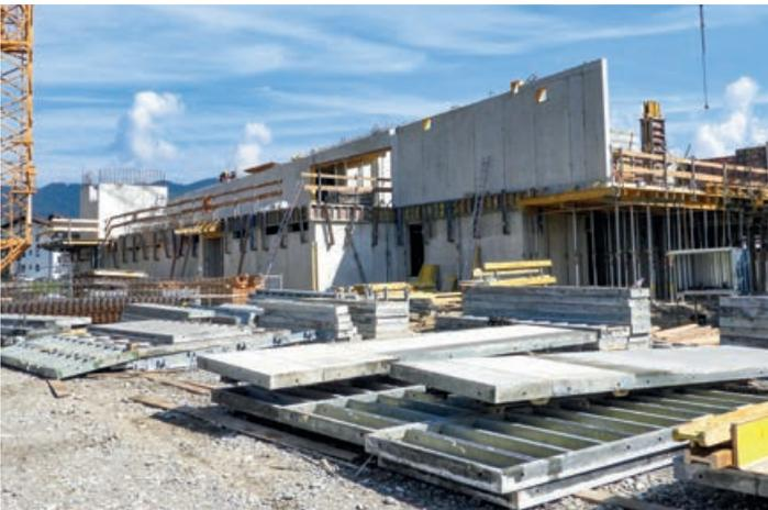
Betonierarbeiten bei den Außenwänden 1. Obergeschoß.
