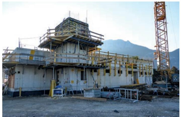
Betonierarbeiten am Schlauchturm.
