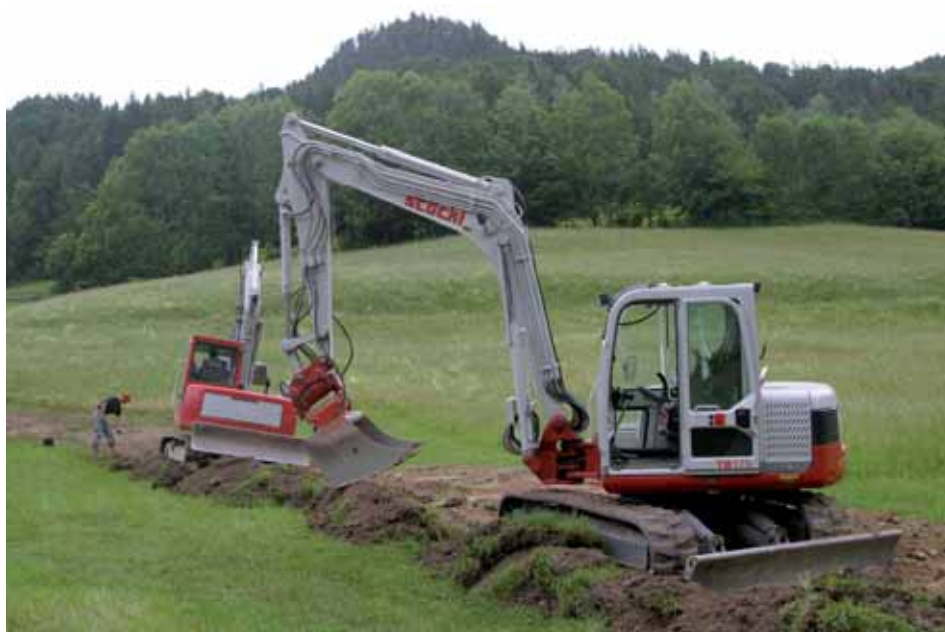
Baggerarbeiten nahe dem Berghof Pfandl.
