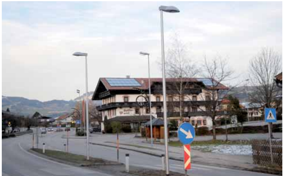
Fußgängerübergang beim „Gschnaller“ in Oberndorf mit neuer Beleuchtung ausgestattet.
