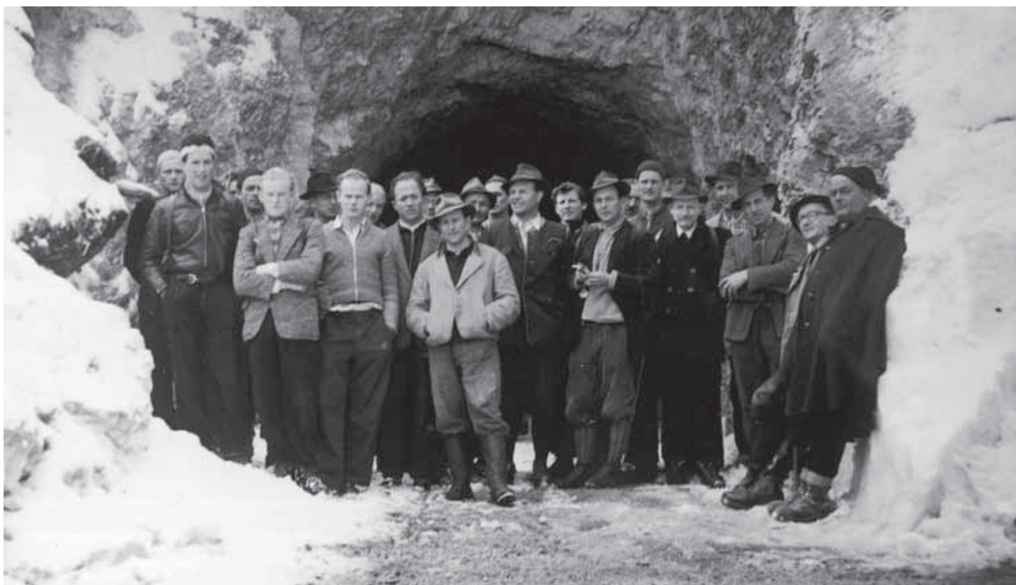
Tunnelbau im hinteren Kaisertal in den 50er Jahren (1. Reihe: 3. von links: Georg Schönauer).
