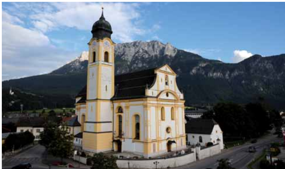
Seit mehr als 250 Jahren prägt die mächtige Pfarrkirche das Ortsbild von Ebbs (heuer wird die Friedhofsmauer saniert).
