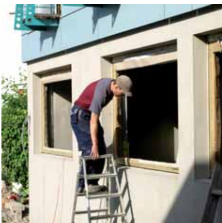
Die Bewohnerzimmer im Parterre Altbau Süd/Ost werden Ende Juni bereits bezugsfertig sein.
