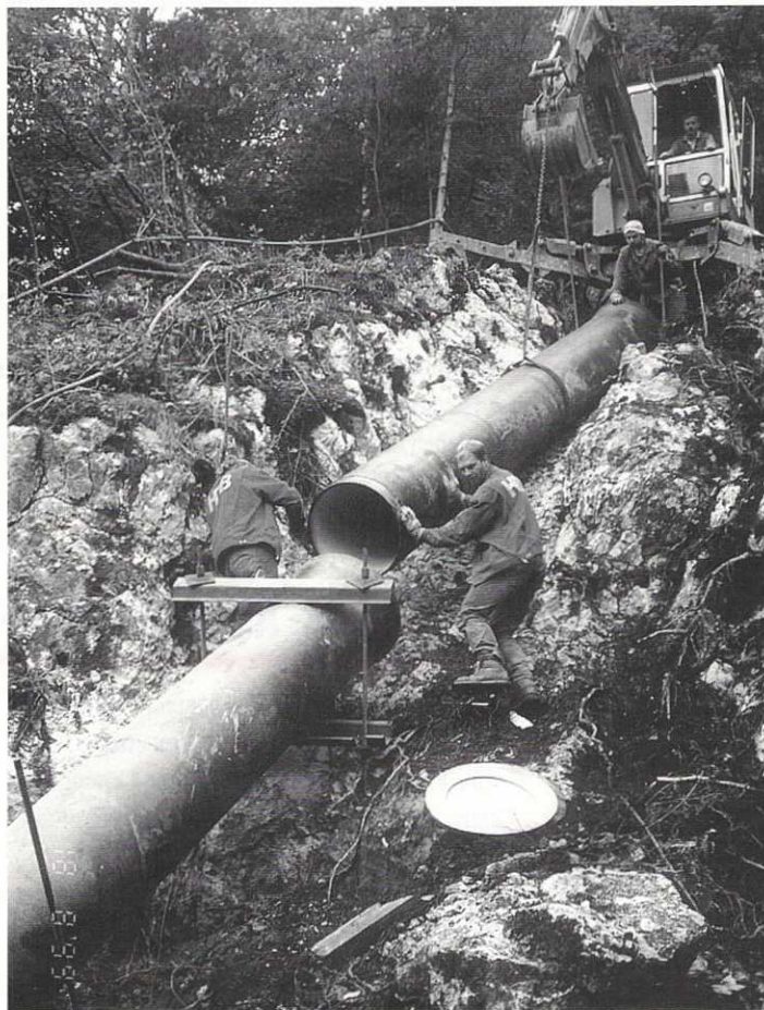
Eine besondere Herausforderung an die Bauarbeiter war die Verlegung der Druckrohrleitung am felsigen Aufstieg ins Kaisertal
