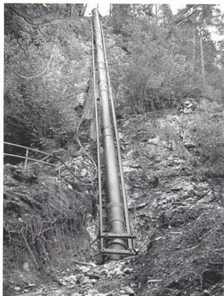
Parallel zur Druckrohrleitung wurde die Kanalleitung verlegt
