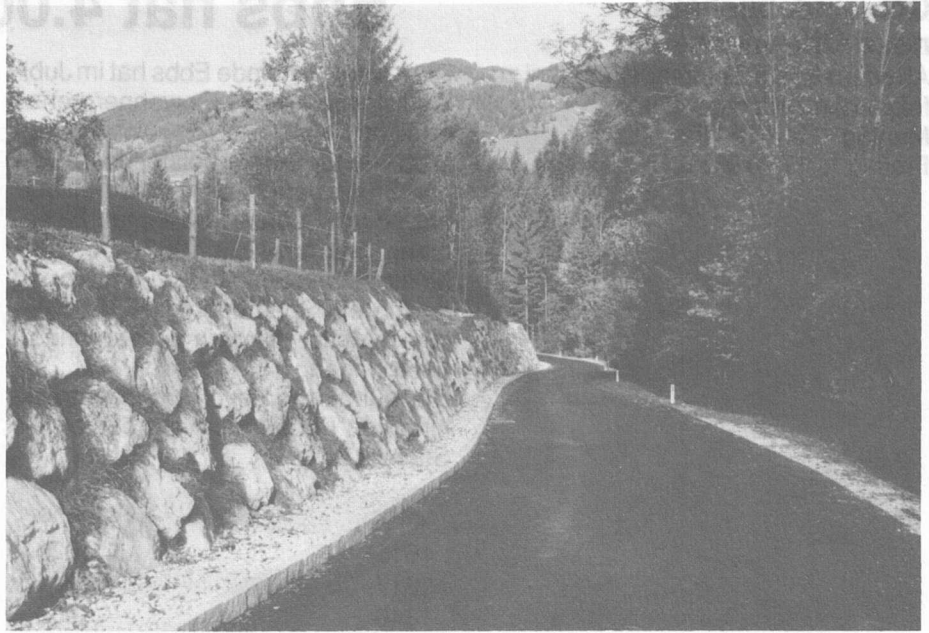
Landesstraße Buchberg: im heurigen Jahr wurde unter Mitbeteiligung der Gemeinde Ebbs die Landesstraße in Buchberg landschaftsschonend generalsaniert, umfangreiche Stützmauerbauten waren notwendig. Herzlichen Dank an die Landesstraßenverwaltung für die gelungene Ausführung.
