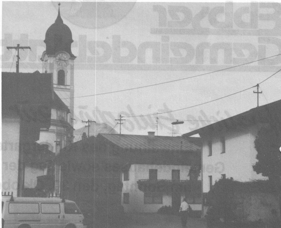
Kabelsalat in der Kaiserbergstraße soll bald der Vergangenheit angehören.
