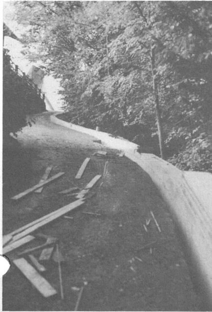
St. Nikolaus erhält eine sichere Zufahrt.
