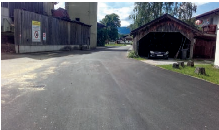
Im Bereich Tafang konnte am Sägewerk der Asphaltbelag erneuert werden.
