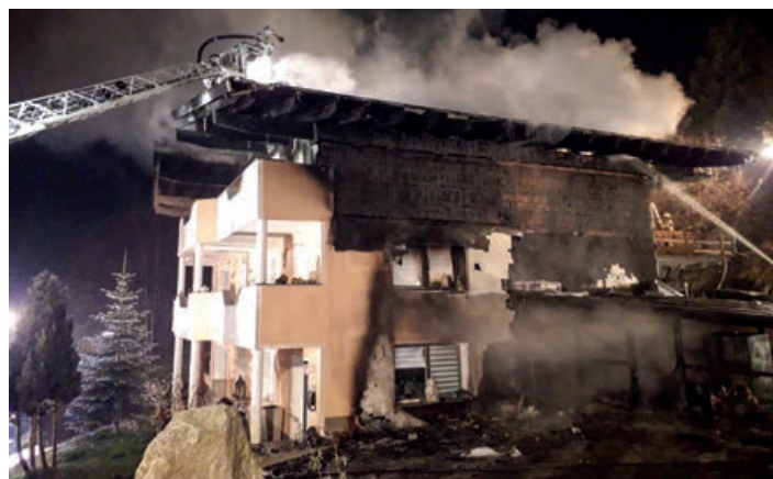
Beim Gebäude entstand erheblicher Sachschaden.
