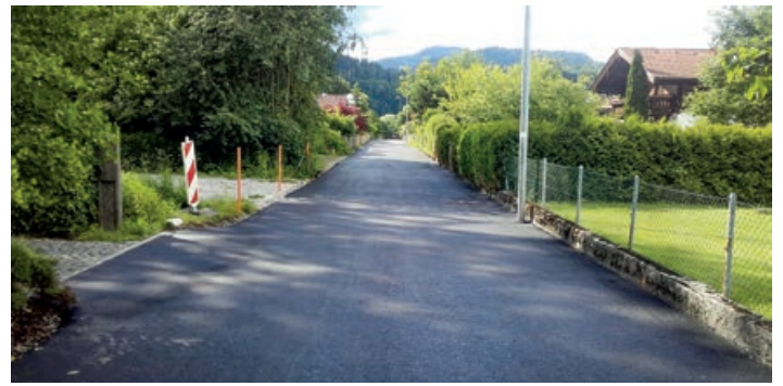
Auch in anderen Bereichen, hier zum Beispiel in Eichelwang, wurden Sanierungen der Asphaltoberfläche durchgeführt.
