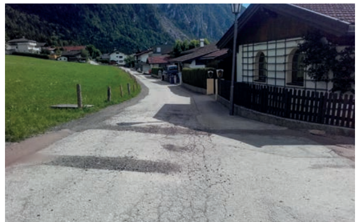
Zudem wird die Verkabelung der Straßenbeleuchtung erneuert.
