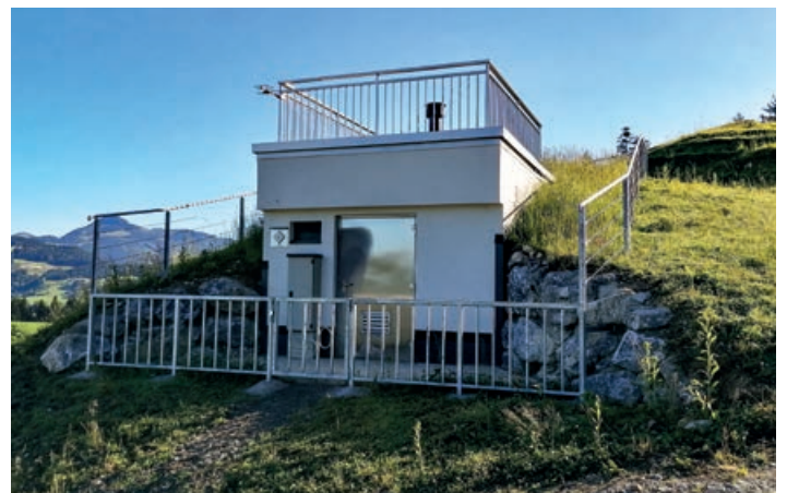
Die erneuerte Dach- und Fassadenkonstruktion.
