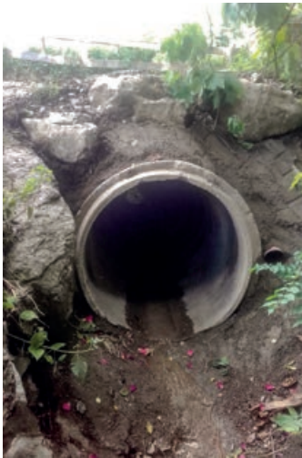
Die Bachverrohrung am Feldberg konnte im Bereich der Straßenüberfahrt ausgetauscht werden
