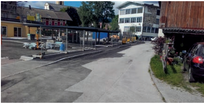
Die Bauarbeiten im Bereich des Postparkes sind aktuell noch im Gange.
