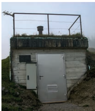
Der Hochbehälter am Oberbuchberg vor der Generalsanierung.
