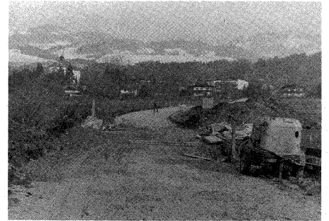
Moosweg: komplett neu ausgekoffert — Asphaltierung im kommenden Frühjahr
