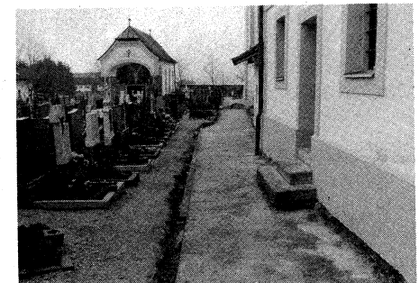
Armierter Untergrund soll Pflaster stabil halten
