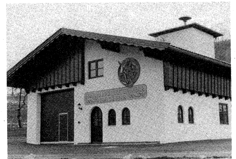
Die Buchberger Wehr hat nun ein modernes Gerätehaus in Buchberg-Asching, das auch als Gemeinschafts- und Schulungsraum anderen Buchberger Vereinen zur Verfügung steht.
