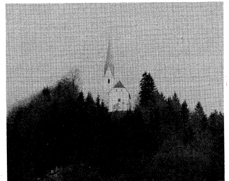
Renovierung abgeschlossen: St. Nikolauskirchlein
