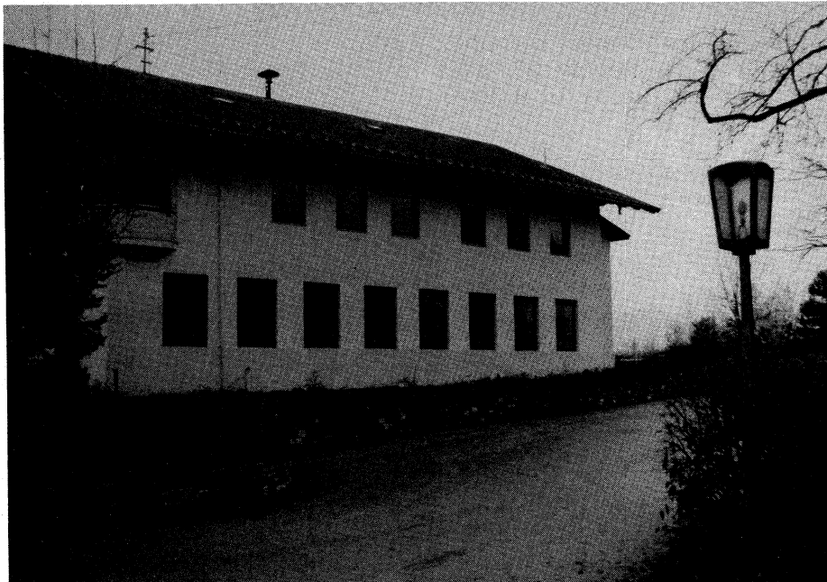
Kindergarten zu klein: Anbau dringend erforderlich
