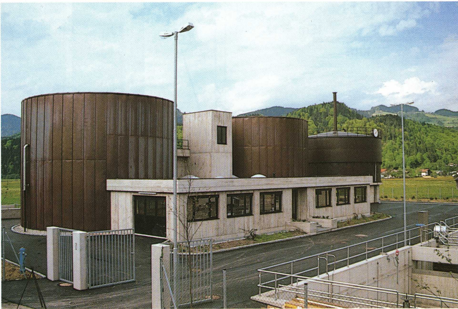
Betriebsgebäude südlicher Trakt
