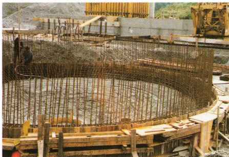
Betonierarbeiten Bodenplatte Faulraum
