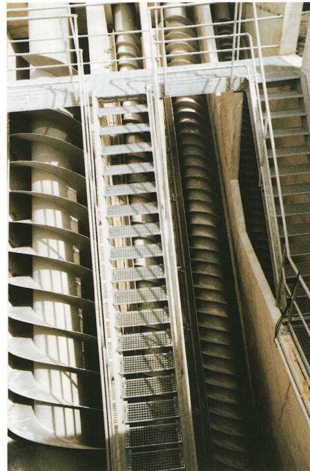
Montage der Regenwasserschnecke
