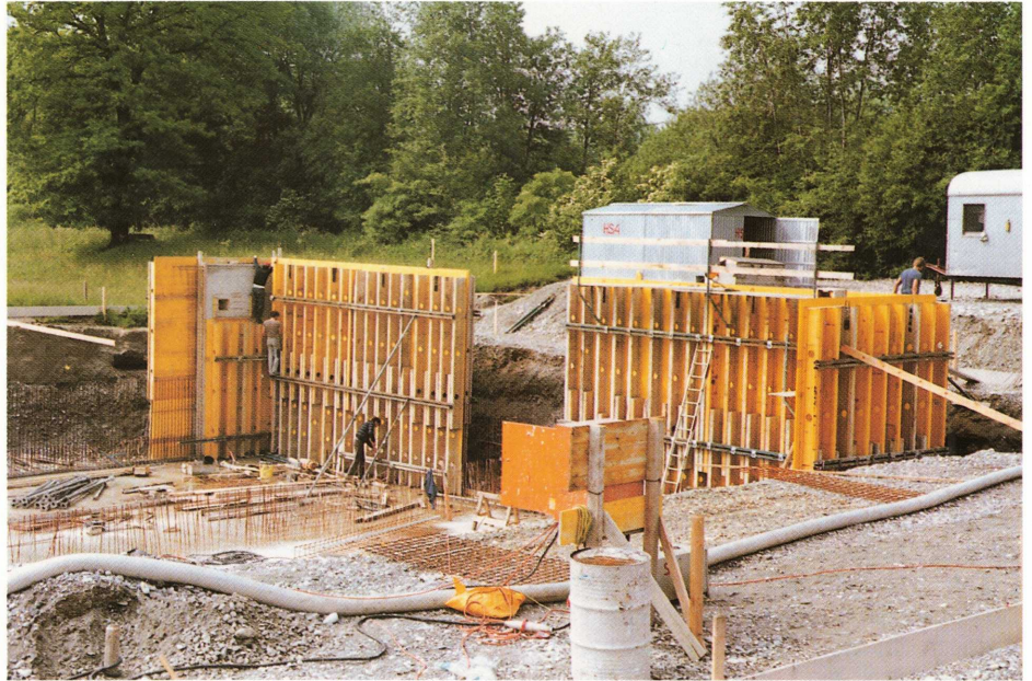
Erste Schalarbeiten am Klärblock
