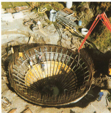
Betonierarbeiten Stapelbehälter, Voreindicker
