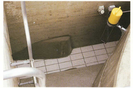
Venturi Mengensmessung
