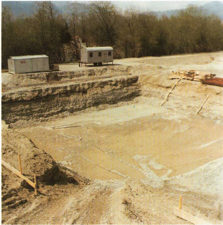
Aushubarbeiten am Klärblock, April 1984
