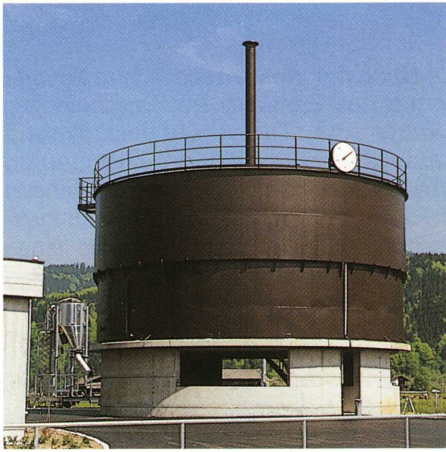
Trockengasometer
