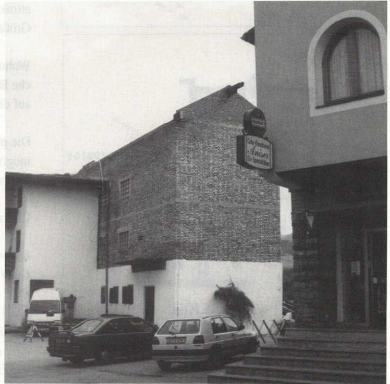
Abbruch des Mühlengebäudes
