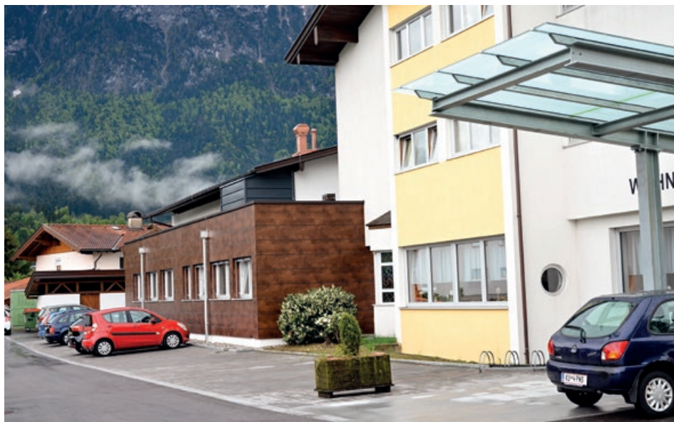
Küchenerweiterung und Eingangsüberdachung im Heim fertiggestellt sowie Roßbachweg generalsaniert.
