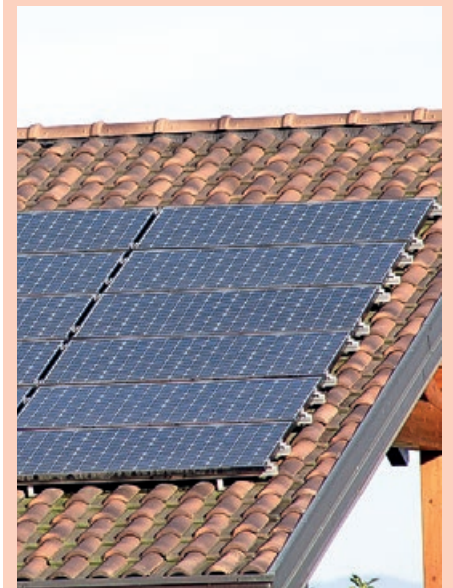
Neben Förderungen für Solaranlagen unterstützt die Gemeinde seit 1. Jänner 2016 auch die Errichtung von Photovoltaikanlagen.
