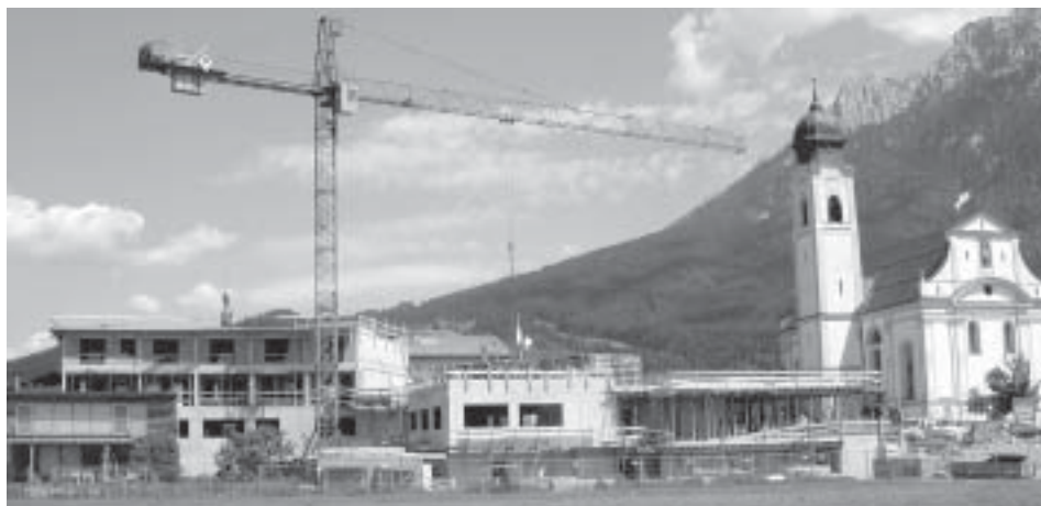
Blick auf den fortschreitenden Rohbau, Pfarrkirche und Zahmen Kaiser.
