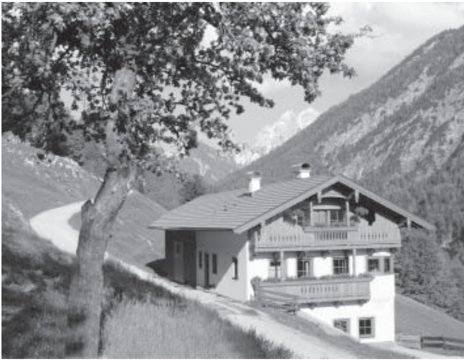
Die Bewohner des Kaisertals bemühen sich mit viel Fleiß um ihre Wiesen, Almen und Wälder. Sie sollen nun nach jahrelangem Tauziehen endlich zumutbare Lebensbedingungen durch einen Weganschluss mit streng reglementierten Benützerbeschränkungen erhalten.
