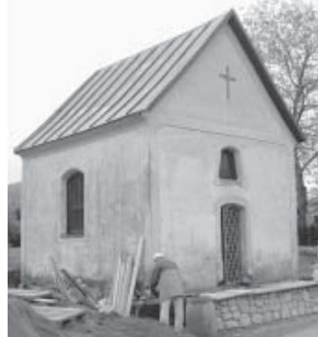
Die Eichelwanger Kapelle wird saniert.
