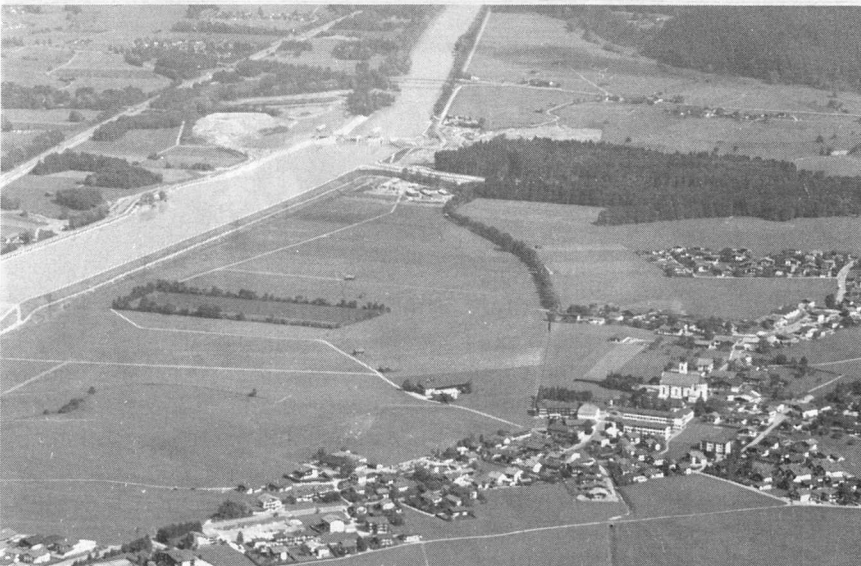
Blick vom Kaisergebirge auf Ebbs und das Kraftwerk
