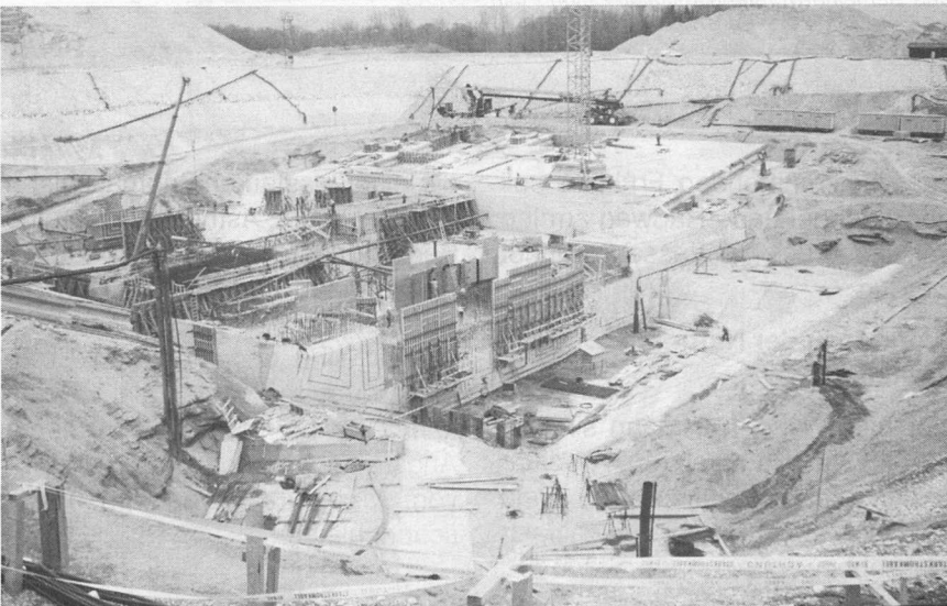
... Ein Bild aus vergangenen Tagen: riesige Betonmengen flossen in das Hauptbauwerk.
