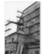
Pfarrkirche Ebbs Fassadensanieru ng 1982 .jpg
