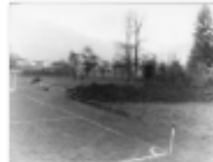
Tennisplatz Ebbs am Jennbach Baubeginn November 197...
