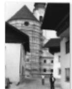
Pfarrkirche Ebbs Fassadensanieru ng 1982.jpg
