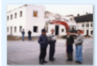
Postwirt Abbruch Ebbs Wildbichler Straße Nr 25 Oktober 1992.jpg
