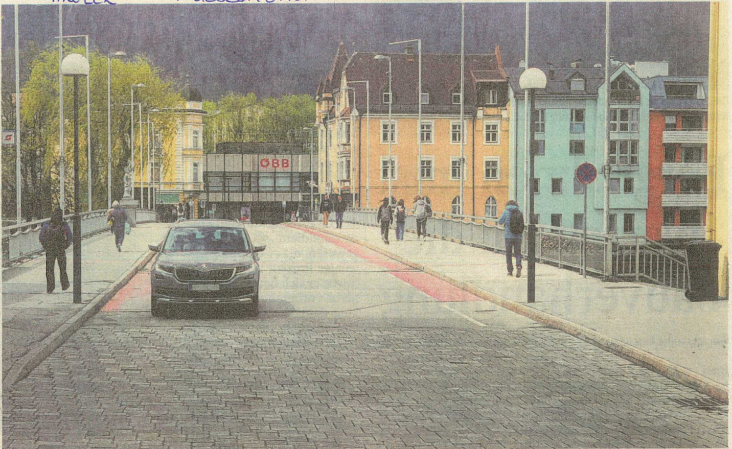
Die Kufsteiner Innbrücke verbindet Stadtteile, aber auch die Begegnungszonen. Um den Lückenschluss gibt es heftige Debatten.
