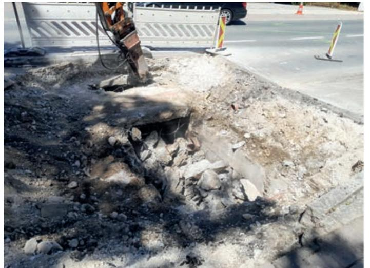
Im Bereich der B175 wurde an der Bushaltestelle mit den Abbrucharbeiten der bestehenden Verrohrung begonnen, ...
