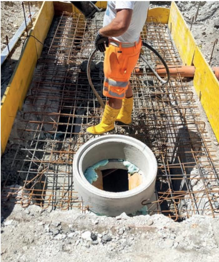
Nach Abschluss der Bewehrungsarbeiten konnte der entsprechende Bereich ausbetoniert werden.
