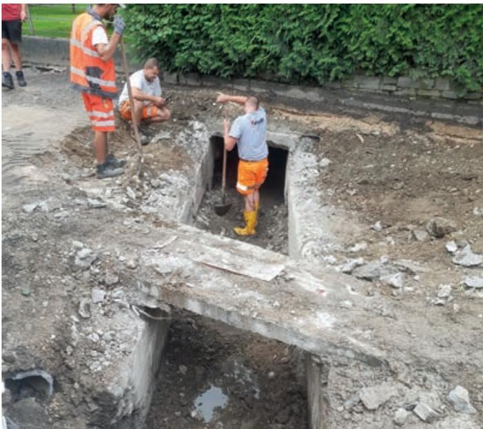
In der Kaiserbergstraße sorgten die einbetonierten Kabel in der Decke für Mehraufwand, ...
