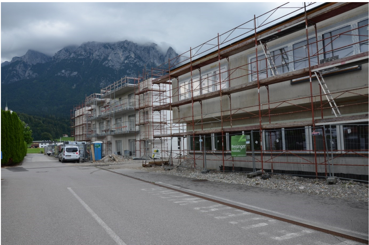
30.7.1922 Erweiterung Sprengelstützpunkt und Altersheim Sozialzentrum 1 sowie Verputzarbeiten Sozialzentrum 2
