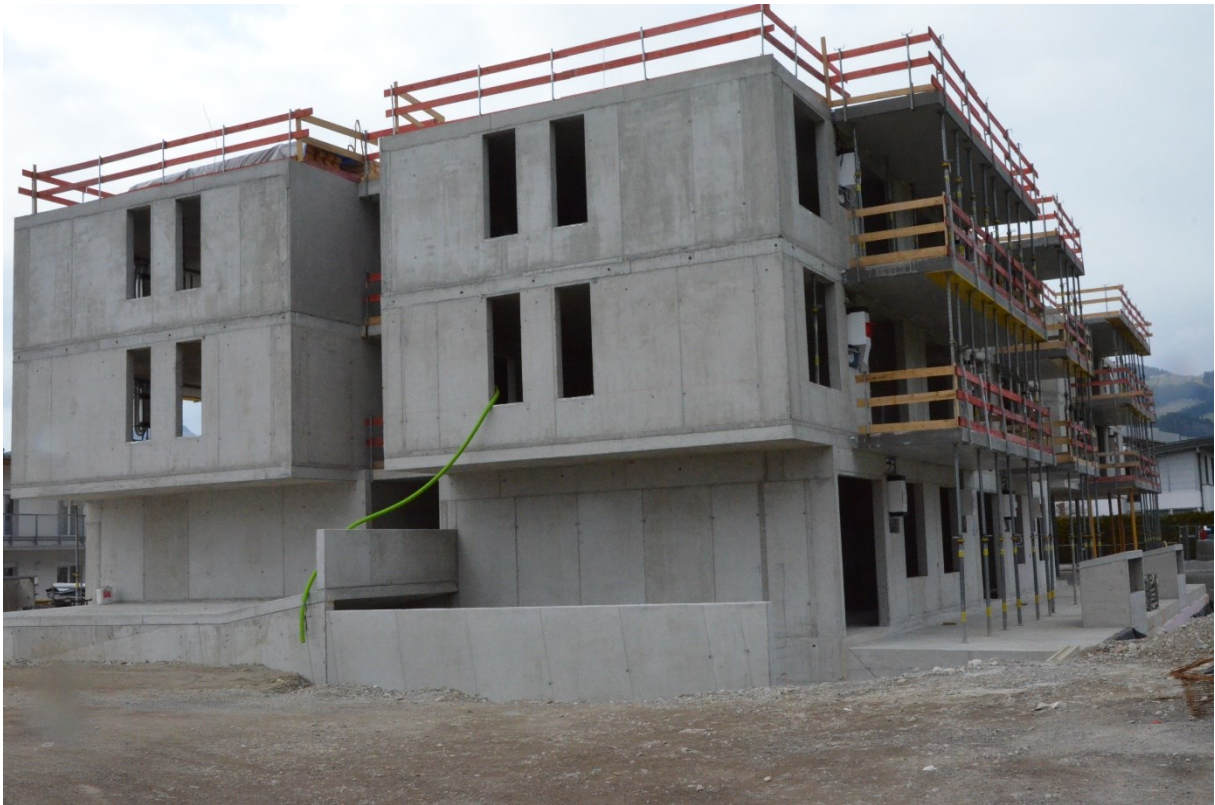
3.4.1921 Tiefgarageneinfahrt, Sicht vom Ebbsbachrundweg
