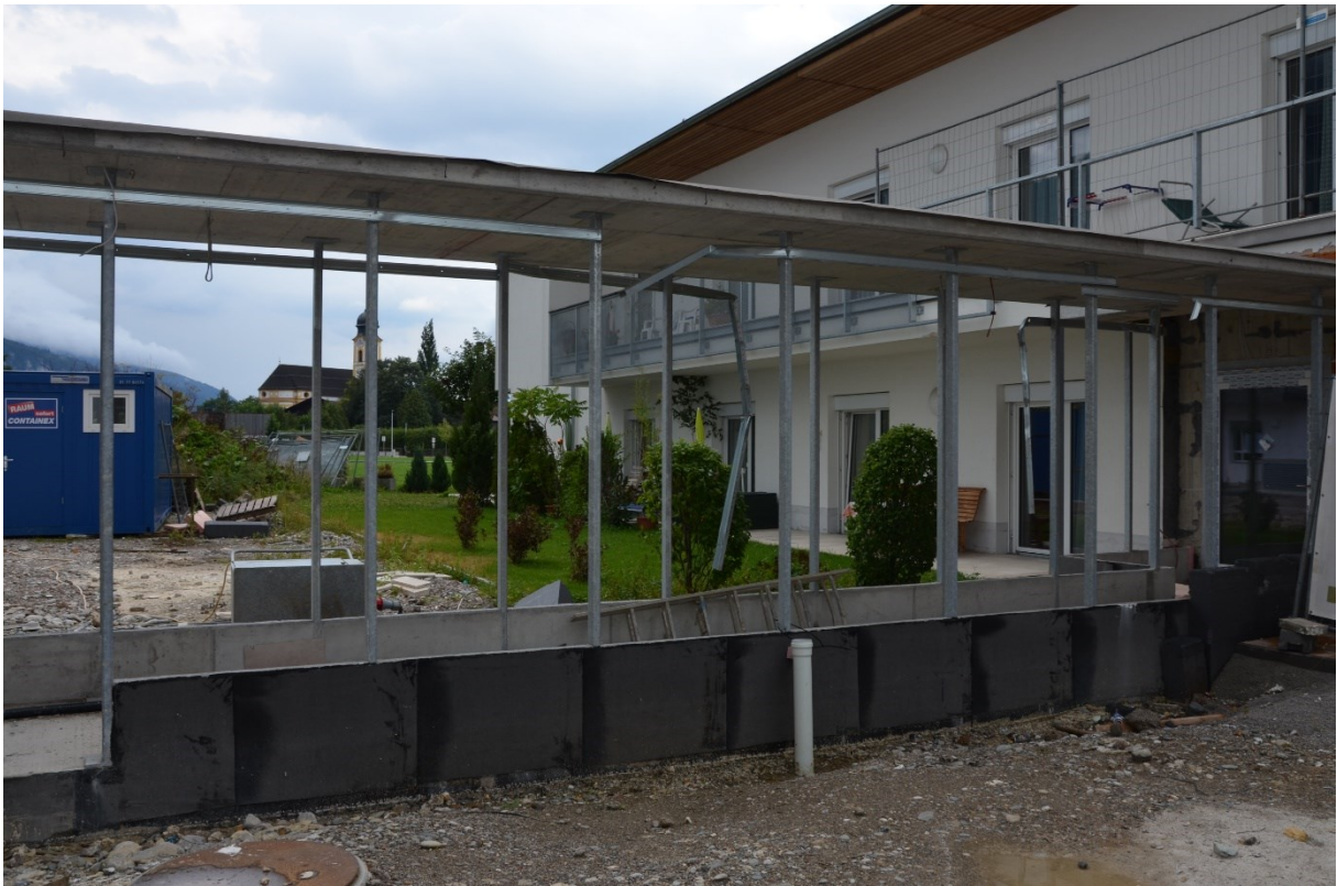
30.7.1922 Verbindungsgang Sozialzentrum 1 zu Sozialzentrum 2
