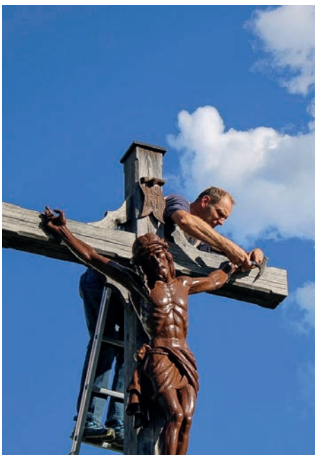
Zimmermeister Georg Ritzer half tatkräftig bei der Restaurierung mit.
