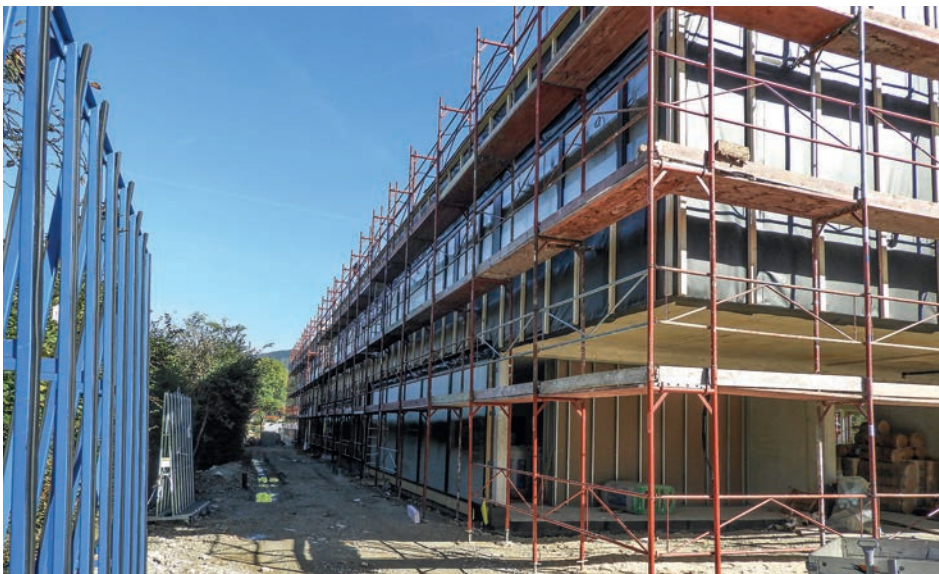
Die Arbeiten an der Außenfassade gehen zügig voran.
