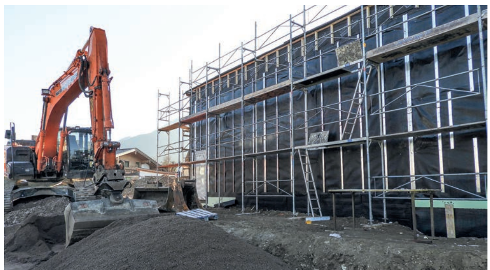
Die Arbeiten an der Fassade, bei gleichzeitiger Herstellung der Außenanlage.
