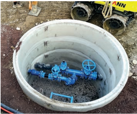
Zur Notversorgung des Wasserleitungsnetzes der Gemeinde Ebbs wurde ein Zusammenschluss mit dem Leitungsnetz der Stadt Kufstein hergestellt.
