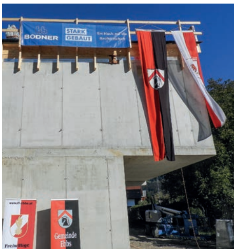
Die Firstfeier des neuen Feuerwehrgerätehauses fand im Oktober statt.
