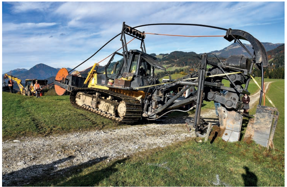
Der Breitbandausbau geht zügig voran. Teile der 170 km langen Internet-Trasse konnten mittels Pflug ausgeführt werden.
