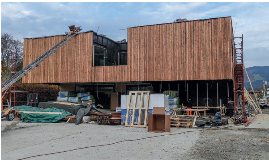
Herstellen der Außenverschalung und der Dachabdichtung.
