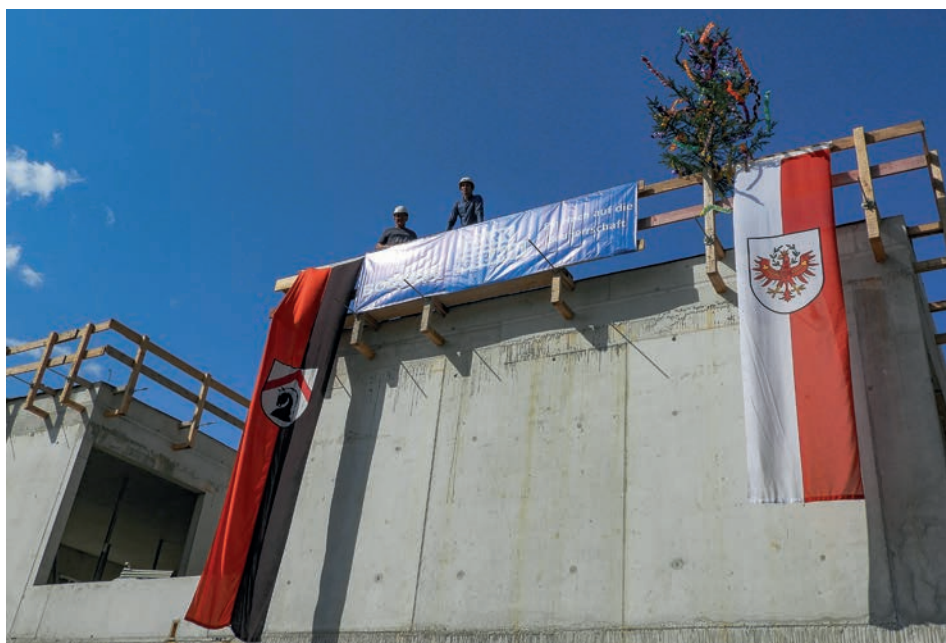
Anfang September fand beim Neubau Kindergarten die Firstfeier statt.
