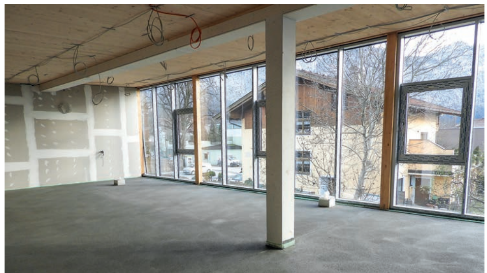
Der fortschreitende Innenausbau, mit Blick in den Schulungsraum im 1. Obergeschoß.
