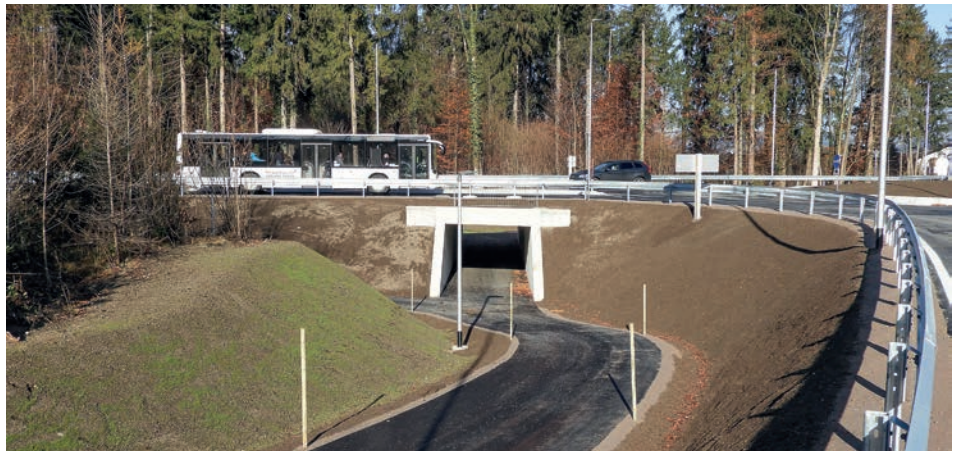
Die Geh- und Radwegunterführung beim neuen Kreisverkehr.
