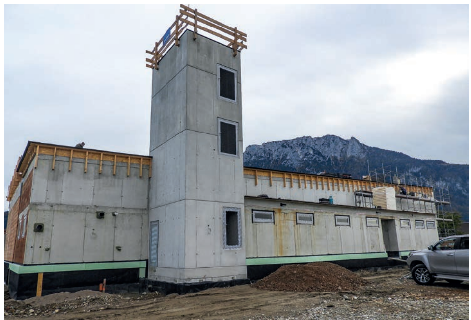
Fertiggestellter Rohbau mit Blick auf den Schlauchturm.
