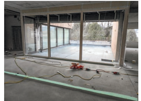
Mit dem Innenausbau wurde bereits begonnen, Blick auf eine der Loggien im ersten Obergeschoß.
