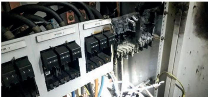
Im Kraftwerk Ebbs-Oberaudorf kam es zu einem Brandgeschehen an einem Elektro-Unterverteiler.
