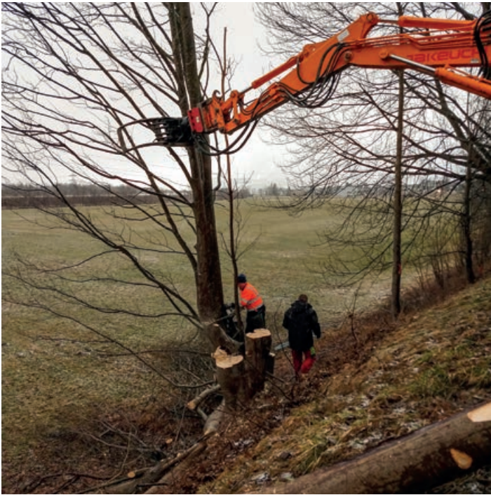
Der Bauhof führte die Rodungsarbeiten für die Abbiegespur durch.
