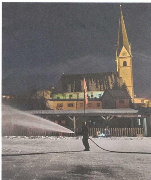
In Schichten wird das Wasser aufgesprüht, damit es rasch friert
