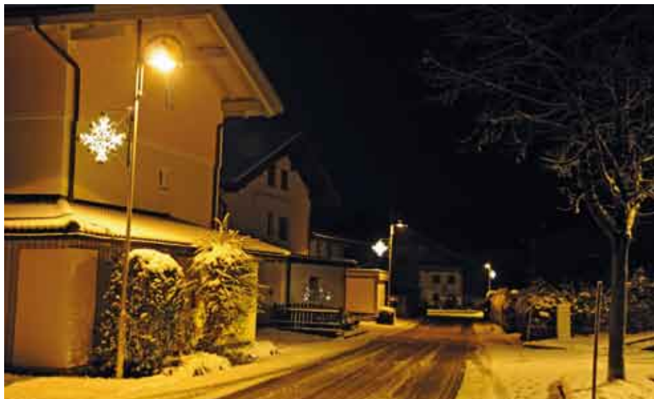
... Saliterergasse wurde die Straßenbeleuchtung erneuert.
