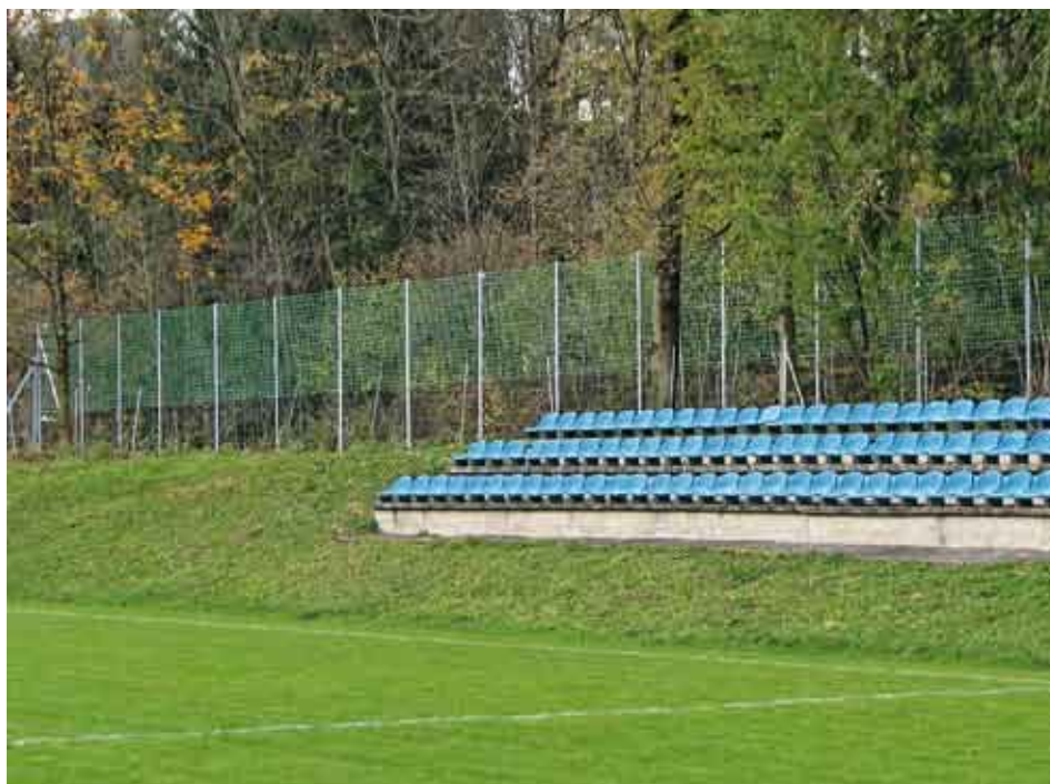
Die neue Einfriedung dient auch als Ballschutznetz.
