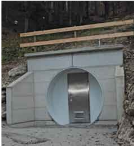
Der Eingang in die neue Brunnenstube „Pfarrerrug“.
