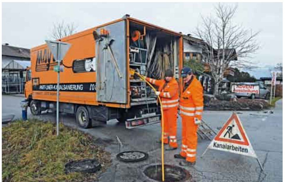
Bruchstellen im Kanalnetz werden im Inliner-Verfahren ohne Grabungsarbeiten saniert.
