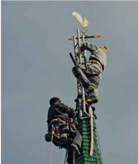
Das Aufsetzen des Turmkreuzes erfordert perfekte Arbeit in luftiger Höhe.
