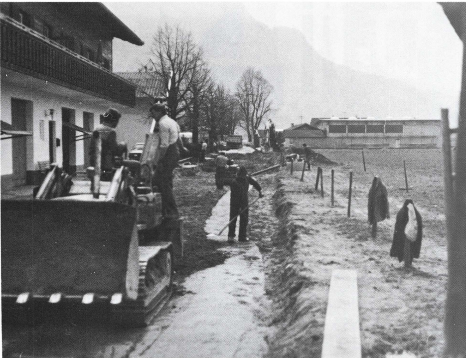
Erste Kanalbaustelle 1981 – Gießenweg
