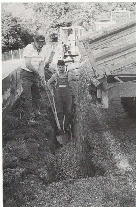
Rechtes Bild: Drainagengraben hinter dem kabinenseitigen Tor.
