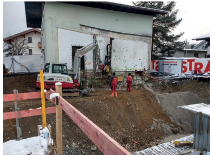
Die Firma HTB beim Setzen und Bohren der Anker mit der Bohrlafette.
