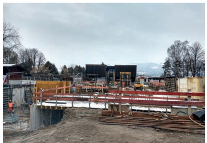
Ende Februar mit noch offener Tiefgarage vom Standort Kaiserbergstraße aus.
