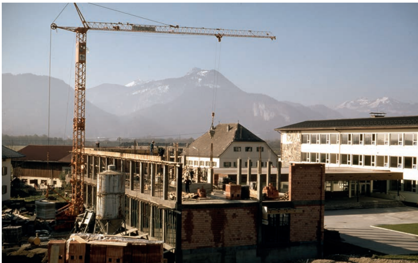
Bau der Volksschule im Jahr 1971.
