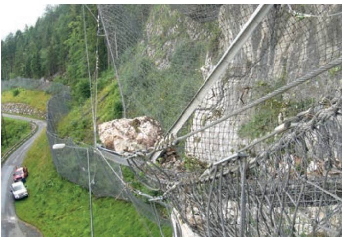
Im vergangenen Jahr wurde der technische Steinschlagschutz einer eingehenden Kontrolle unterzogen.
