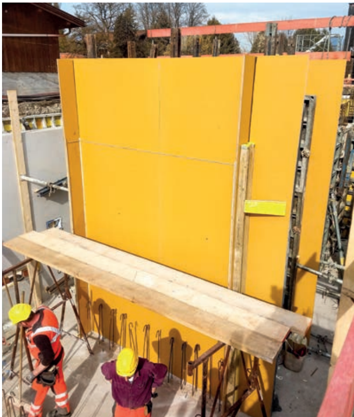
Belegte Stahlschalung für die Erstellung der Sichtbetonwände.
