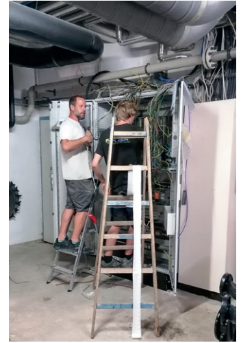
Im Technikraum entsteht eine neue Lüftungs- und Heizungsanlage.
