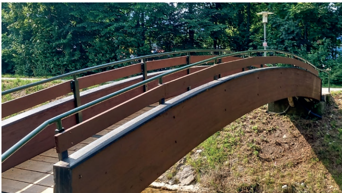
Gemeinsam mit den Mitarbeitern des Gemeindebauhofes aus Niederndorf wurde die Geh- und Radbrücke über den Jennbach im Bereich Oberweidach in Stand gesetzt.
