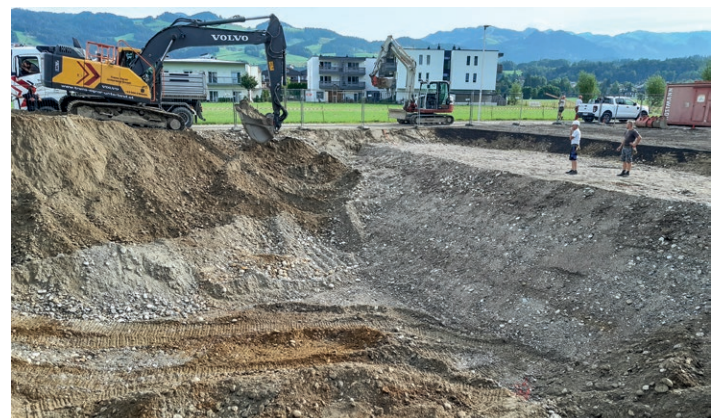
Bestes Aushubmaterial wurde beim neuen Bauplatz vorgefunden.
