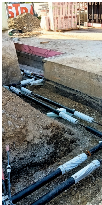
Von der Biowärme Ebbs wurden die Leitungen zum neuen Gemeindezentrum gelegt.
