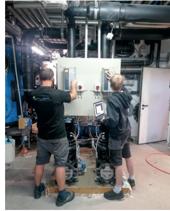
Erneuerung der drei großen Pumpen für das Saunabecken.
