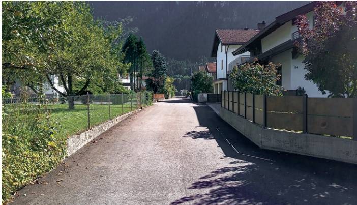
Die fertiggestellte Straße im oberen Oberndorf.
