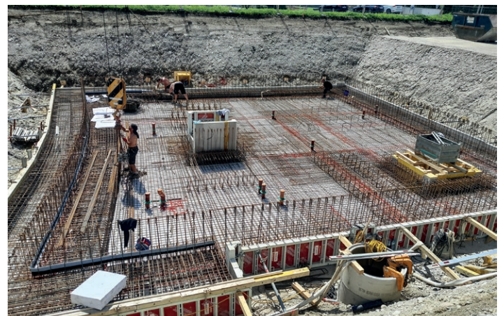
Bewehrung der Bodenplatte im Untergeschoß. Im Bild links zu sehen die gekrümmte Wand des Veranstaltungssaales, welcher im Erdgeschoß untergebracht wird. Nur der mittlere Bereich des Gebäudes wurde unterkellert.
