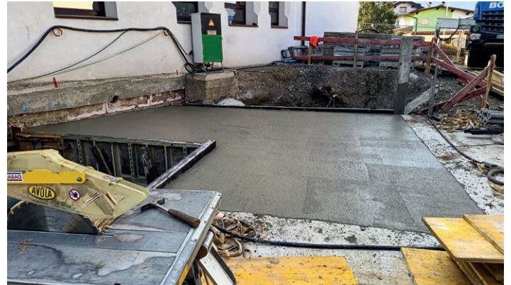
Eine Tiefgarage verbindet das alte mit dem neuen Gemeindegebäude.
