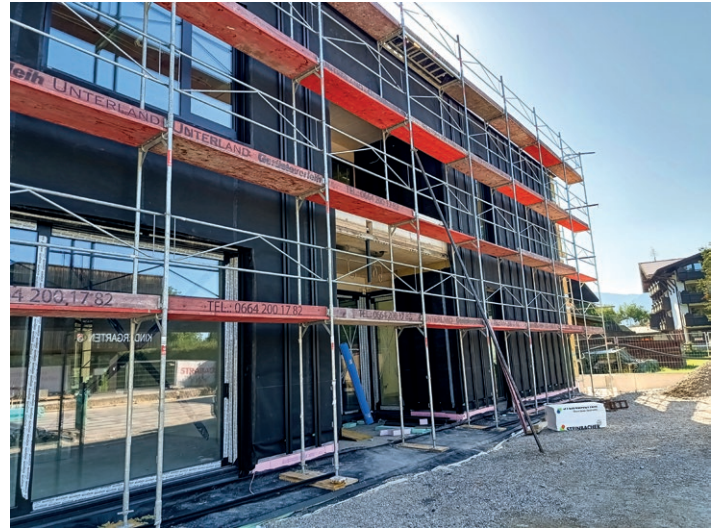
Die Fassade mit der angebrachten Unterkonstruktion für die Keramik. Nordseite des Gemeindezentrums (Blickrichtung vom Eltern-Kind-Zentrum Richtung Kirche).
