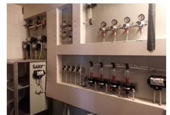
Im Restaurant wurde eine neue Schankanlage eingebaut.
