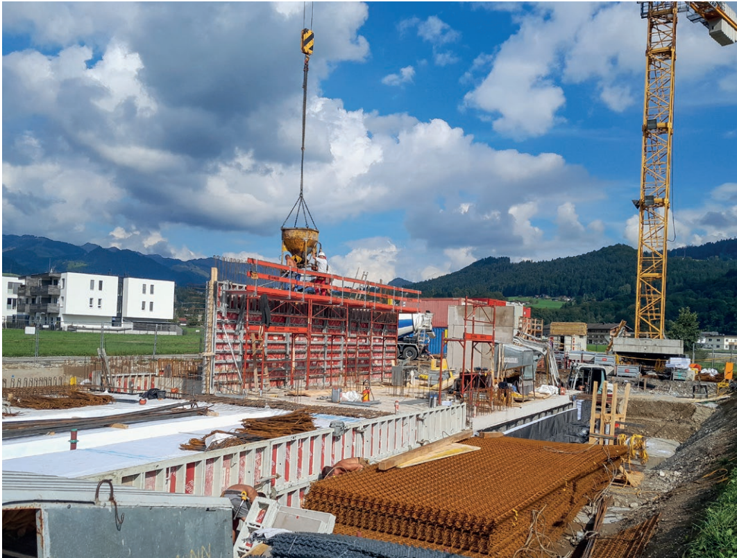
Mitte September starteten die ersten Betonierarbeiten an den Wänden im Erdgeschoß.
