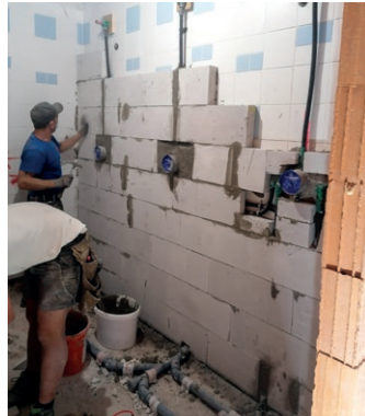
Die Umbauarbeiten für die neuen Umkleidekabinen sind voll im Gange.
