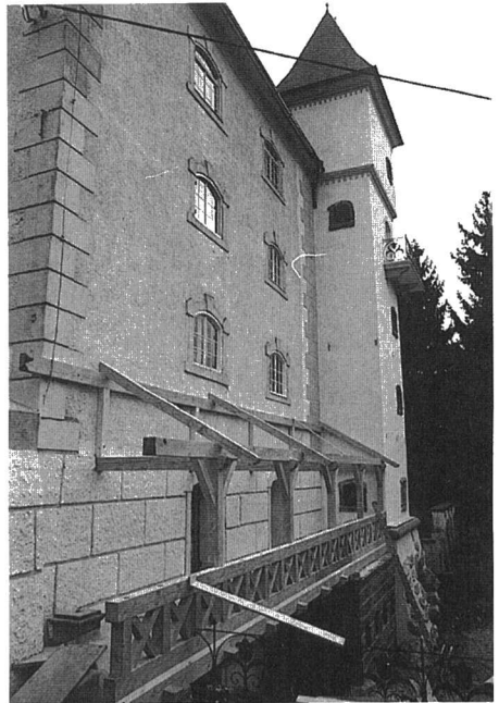
Letzte Baustelle an der Westfront, 1989–90
