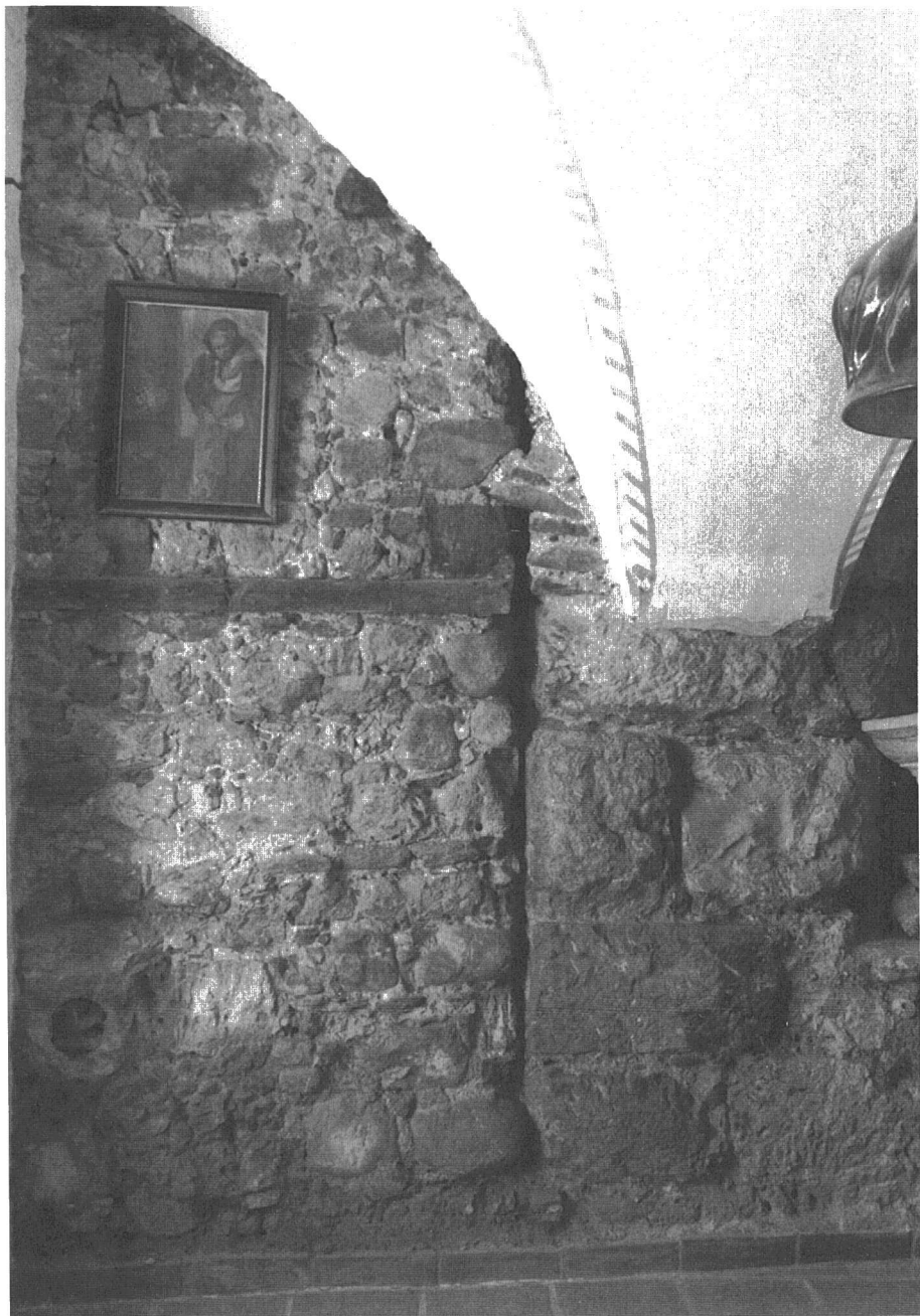
Abb. 6 Abbildung der Nahtstelle zwischen altem Wohnturm und Anbau im ersten Stockwerk. Freigelegt und aufgenommen September 1992.
