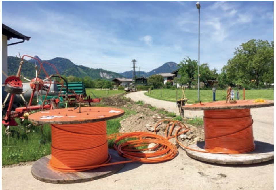
Die Gemeinde Ebbs startete die Errichtung eines modernen Glasfasernetzes im Ortsteil Oberndorf.
