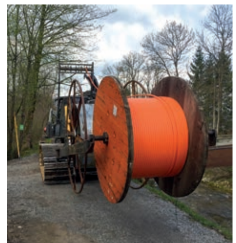
Verlegearbeiten für schnelles Internet im Bereich des Jennbachdammes.
