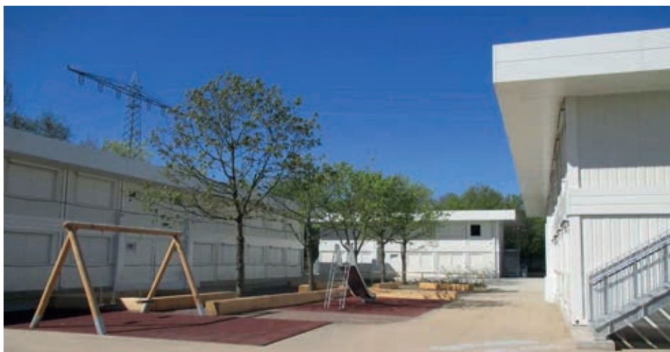
Wohnheim für Flüchtlinge aus RECON-Raummodulen für die Stadt Freiburg im Breisgau.
