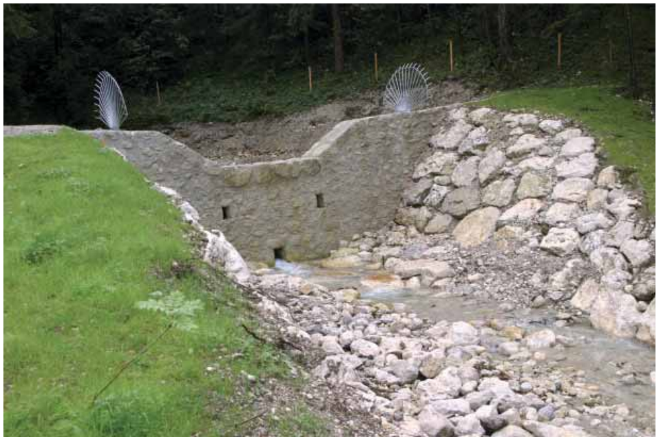
Die Kiesfalle am St. Nikolausweg wurde ausbaggert und fachgerecht erneuert.
