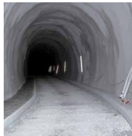
Die Tunnelauskleidung ist fertig. Die Randsteine, die die Fahrbahn begrenzen, sind verlegt.
