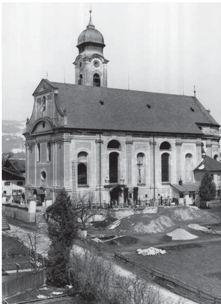
Bau der ersten Friedhofskapelle mit der ersten Friedhoferweiterung im Pfarrgarten (1954).
