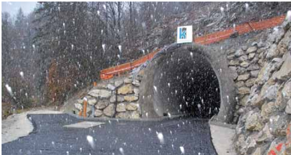
Die Zufahrtsstrecke zum Nordportal hat bereits die untere Asphalttragschicht.
