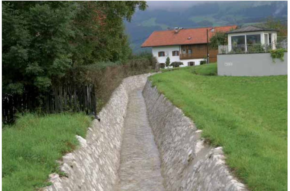
Das Gerinne des Heubaches ist am Plafingerweg jetzt wieder sicher.
