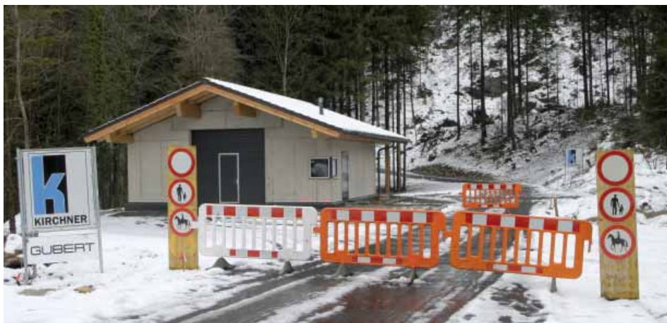
Das Lagergebäude (mit integrierter Tunnelwarte) dient der Zwischenlagerung von Waren.
