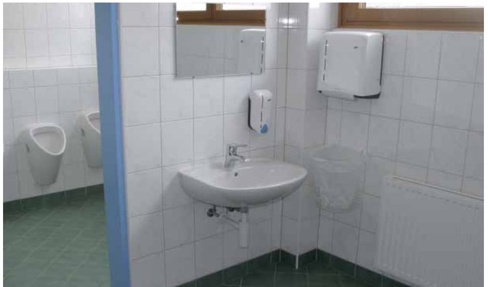
Die Sanitäranlagen in der Volksschule wurden auf den neuesten Stand gebracht.
