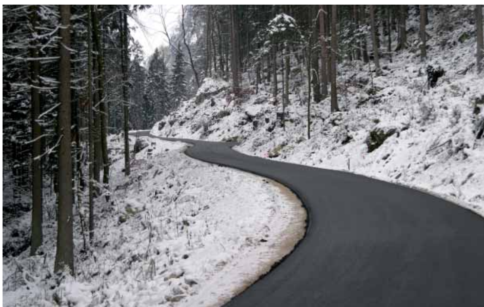
Die Zufahrtsstrecke zum Südportal ist bereits asphaltiert. (Fotos: Hansjörg Dag, Anton Geisler)
