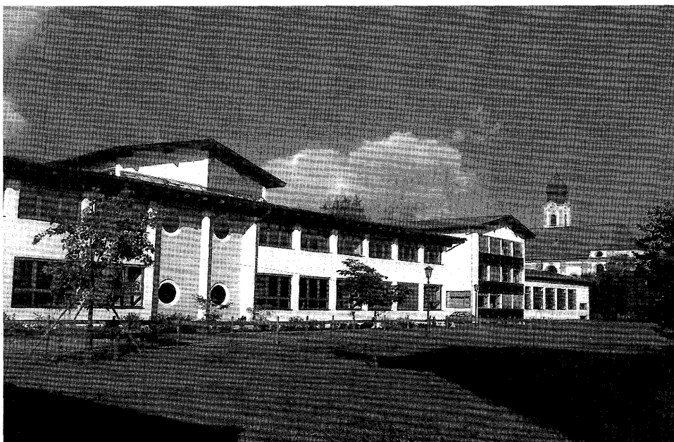
Sechs neue Klassenräume sind entstanden
