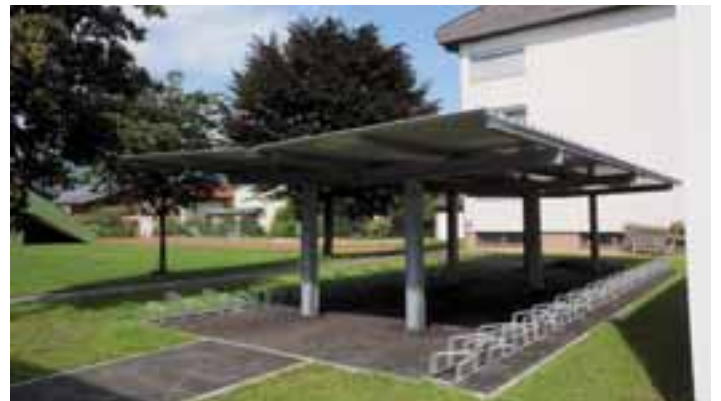
Die Fahrradunterstände befinden sich nun auf der Ostseite mit Zugang von der Saliterergasse.
