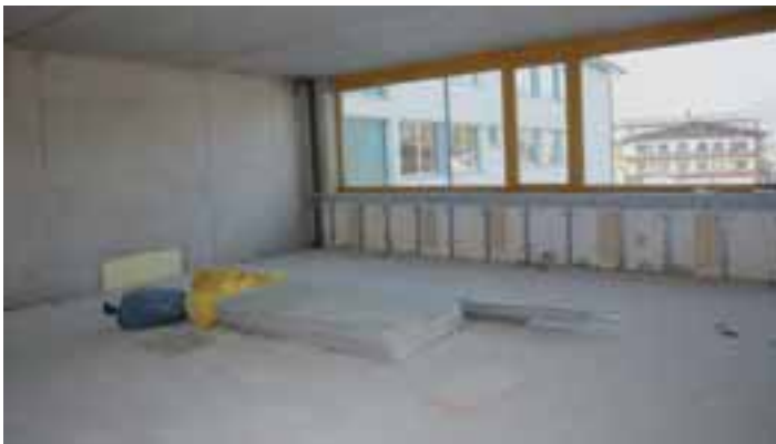
Über dem Foyer entstehen drei neue Schulklassen.
