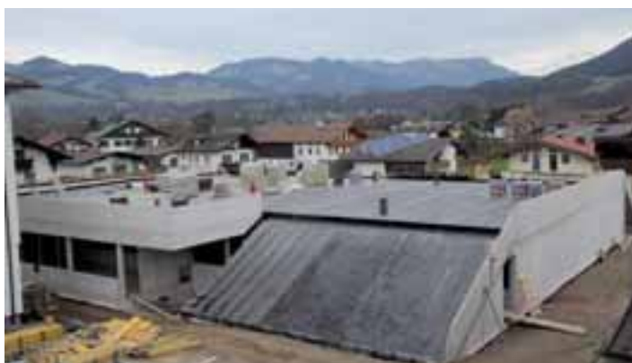
Die Sporthalle und der Raum für die künftige Nachmittagsbetreuung sind bereits im Rohbau fertig.
