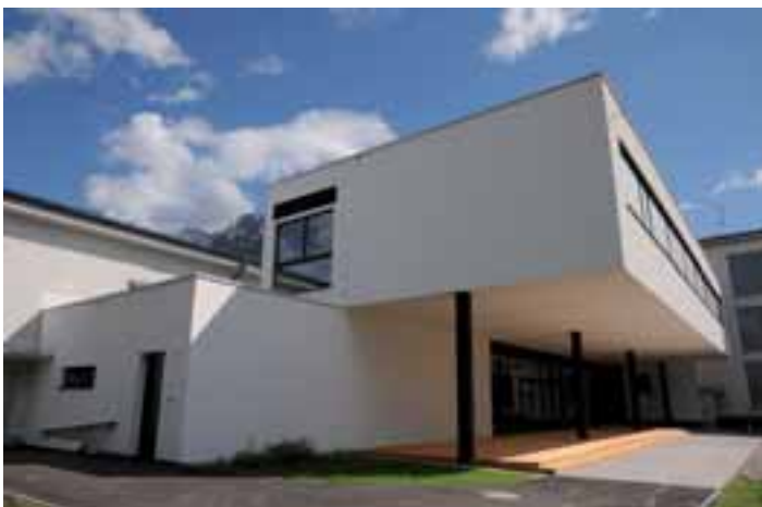
Die Hauptschule wurde um drei Klassen und einen Medienraum erweitert.
