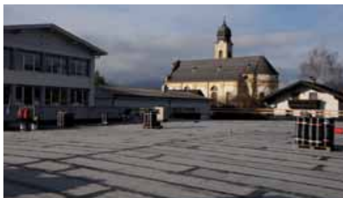
Blick über das Sporthallendach zur Hauptschule und zur Kirche.
