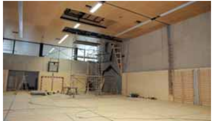
Die Wand für das Vorstiegsklettern wird montiert.
