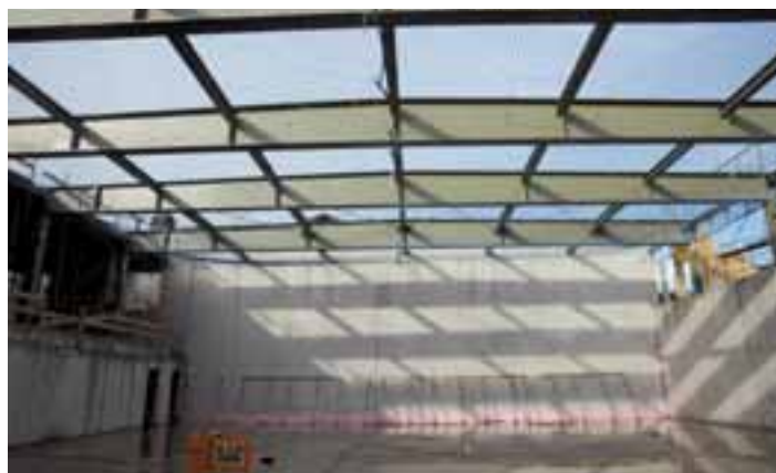
Die Stahlträger für das Dach sind bereits aufgesetzt.
