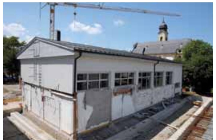
Die Fundamente für das Foyer und die neuen Nassräume sind bereits ausgeführt.
