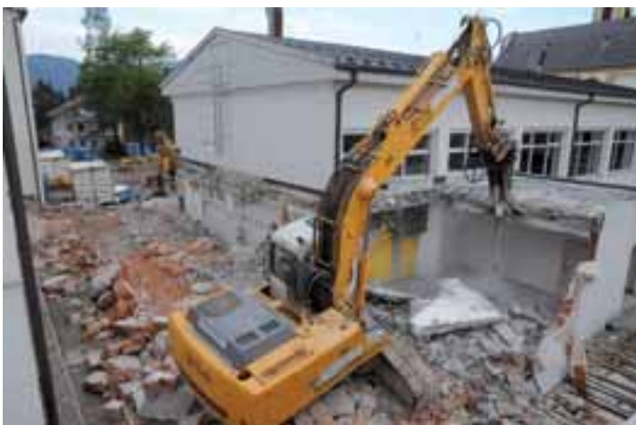
Der vormalige Geräteraum wird abgetragen. Hier entsteht das Foyer mit Zugang zur Mehrzweckhalle und zur Sporthalle.
