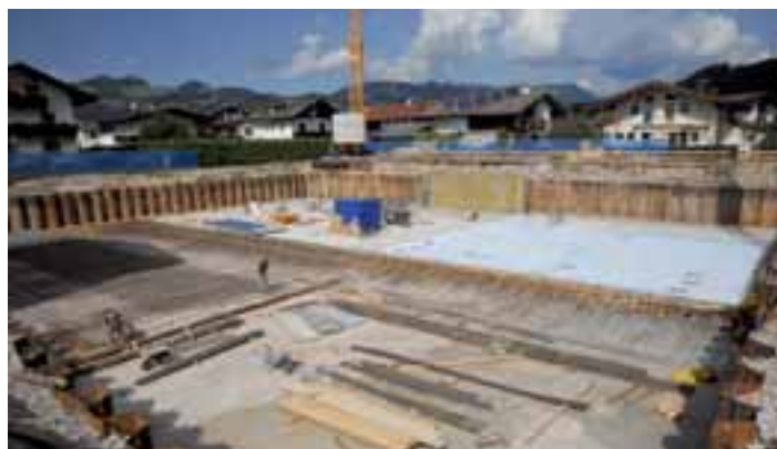
Zwei Teile der Fundamentplatte, die in vier Abschnitten betoniert wurde, sind schon fertig.
