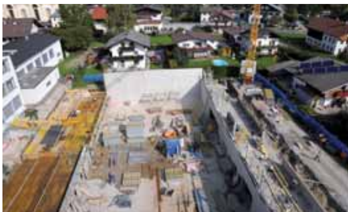
Blick auf das Untergeschoss aus der Kranperspektive.
