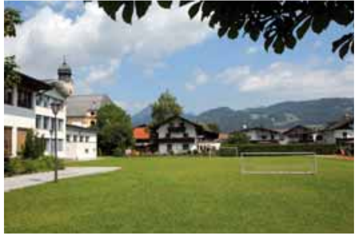
Auf dem Schulsportplatz wurde die Zweifach-Sporthalle errichtet.
