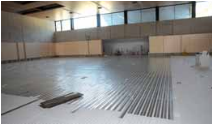
Im Fußboden wird die Heizung installiert.
