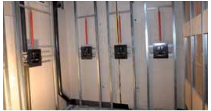
Die Rohinstallation für die Nassräume hat begonnen.
