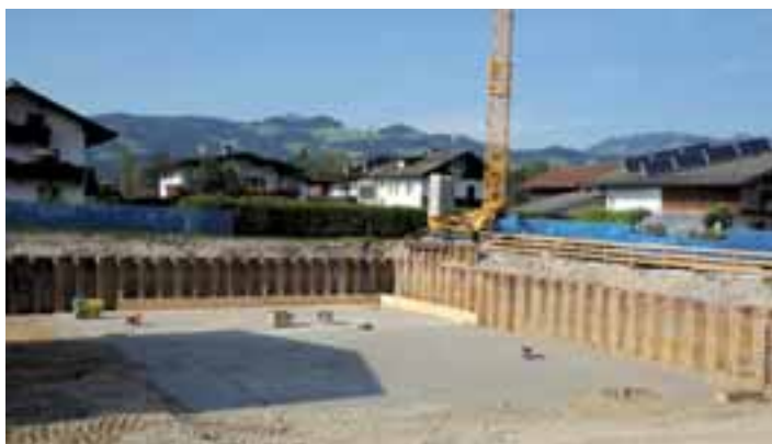
Die Baugrube wurde mit Spundwänden abgesichert.
