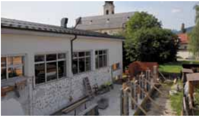
Die neuen Nebenräume (Umkleiden, Duschen und WC-Anlagen) der Mehrzweckhalle entstehen an der Ostseite.
