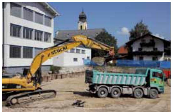
Humusabtrag auf der Baustelle.
