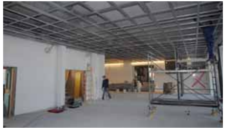
Die Deckenkonstruktion für das neue Foyer wird errichtet.
