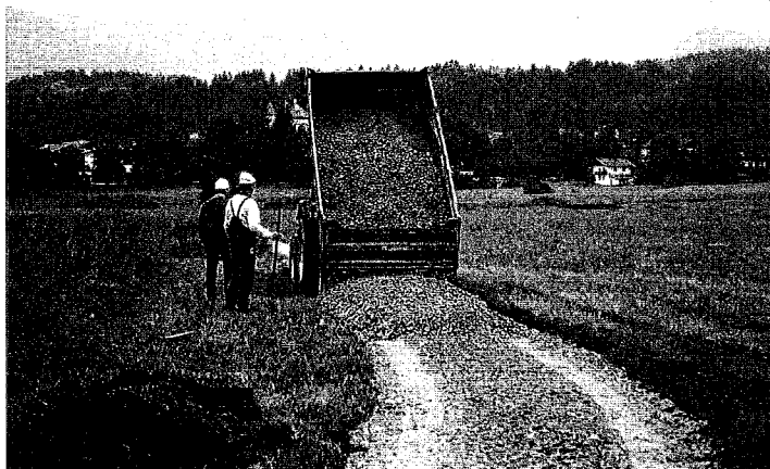
Nun kann der Weg vom Altersheim zur Schloß- allee auch bei nassem Wetter benutzt werden: der alte Weg wurde verlegt und ausgekoffert.
