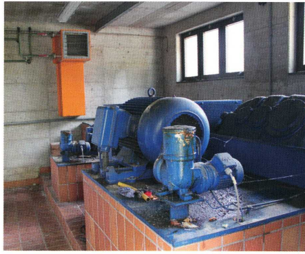
Motorenraum Schneckenantriebe
