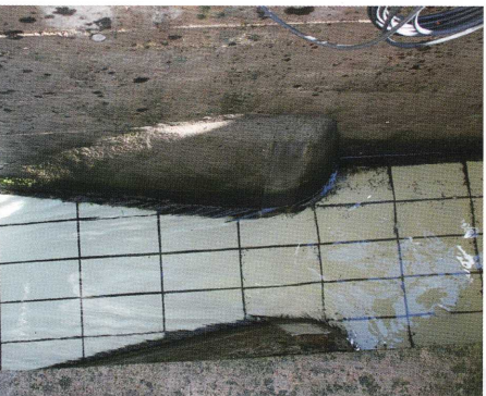
Ablaufkanal mit Mengenmessung
