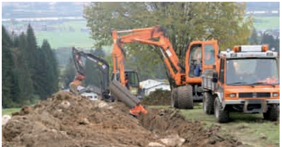
Die Mitarbeiter des Bauhofes beim Verlegen der Wasserleitung.
