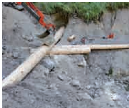
Der Stamm, der die Schwelle bildet, wird tief in die neue Böschung eingelassen.
