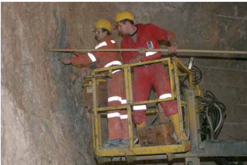
Die Mineure füllen die Bohrlöcher mit Sprengstoff.
