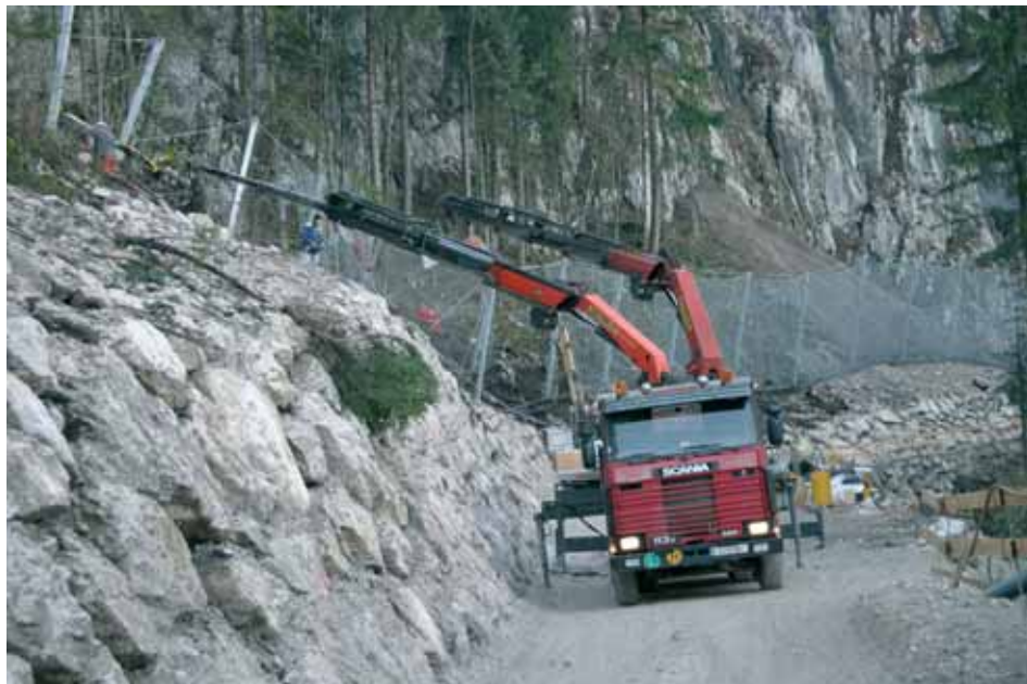
Errichtung von Schutznetzen entlang der Zufahrtsstraße zum Tunnel.
