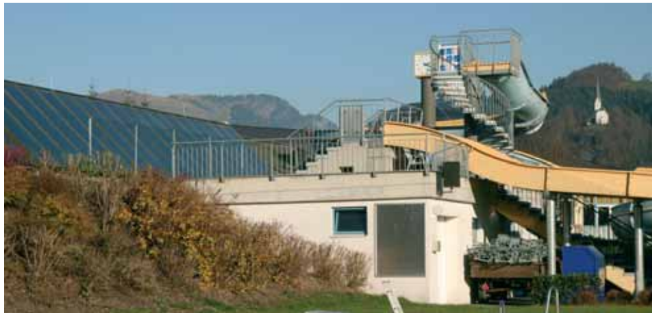
Die Solaranlage beim Hallo Du hilft Engeriesparen.
