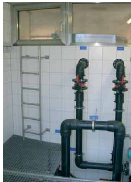
Die Schieberkammer des Hochbehälters Oberbuchberg wurde zeitgemäß saniert.
