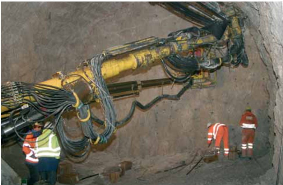
Die riesige Bohrmaschine im Einsatz. An der Tunnelbrust sind die Bohrlöcher gut sichtbar.
