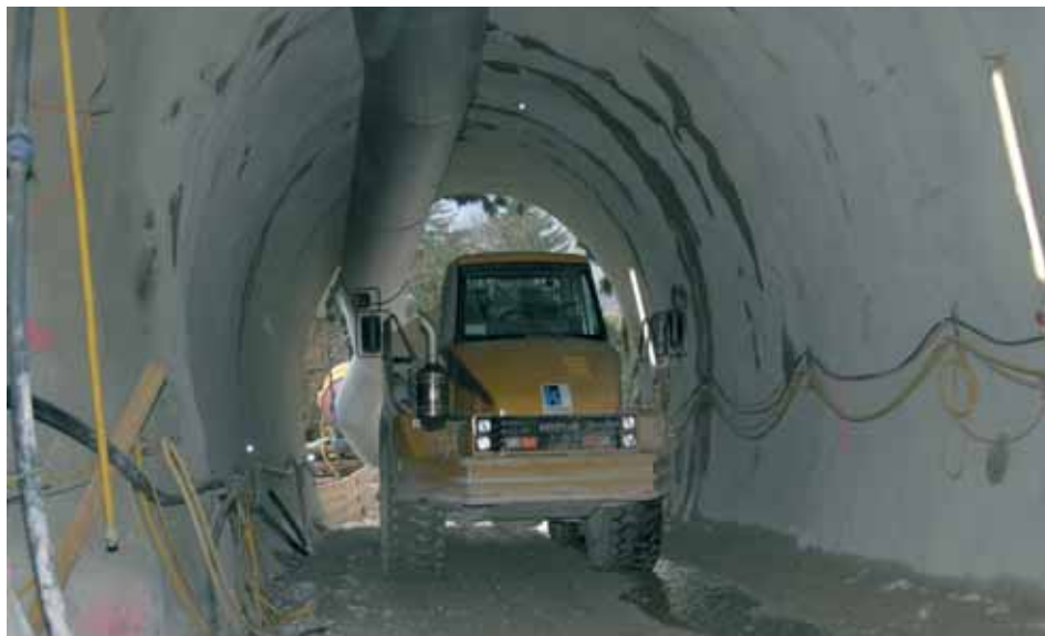
Zum Abtransport des Ausbruchmaterials fährt der Muldenkipper in den Tunnel ein.
