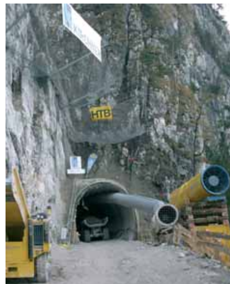
Der Tunnelvortrieb geht zügig voran.
