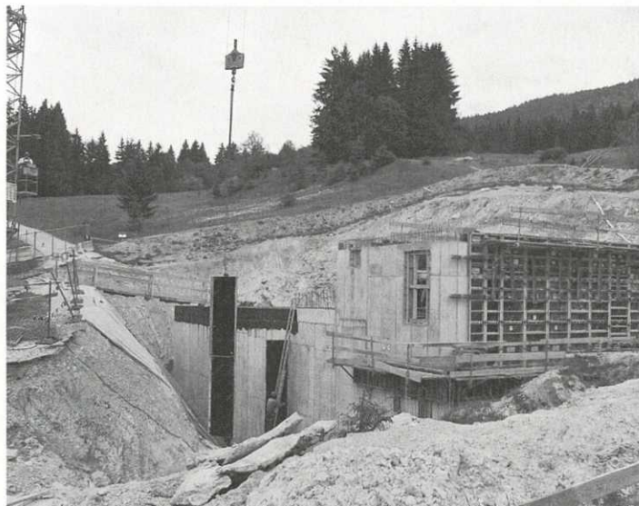
Der neue Hochbehälter nimmt konkrete Formen an (Ende Mai 2001).
