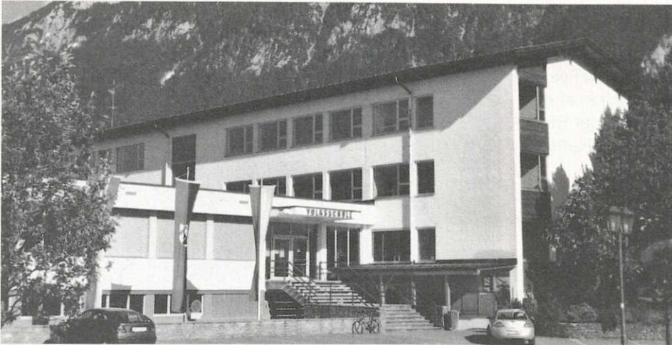
Nach der Hauptschule wird auch die Volksschule saniert.
