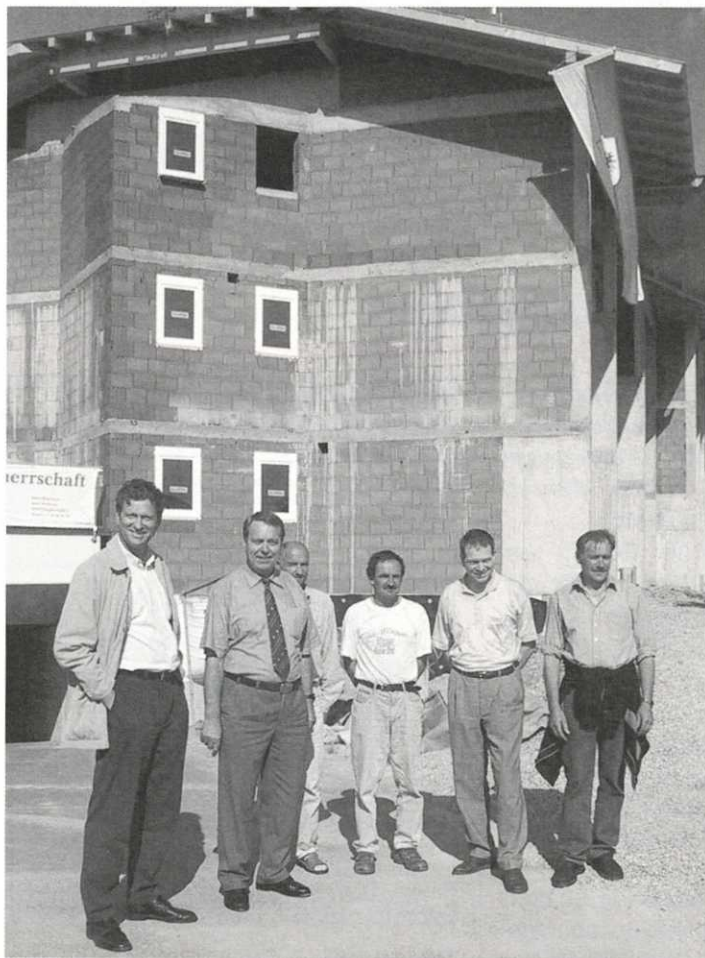
Firstfeier am 13. Juni - v.l.n.r.: CGO-Gf Hermann Oberreiter, Bgm. Josef Astner, Gerhard Zerlauth (Bauamt), Herr Wörgötter (Zimmerei Mitterer), Planer Bmstr. Anton Gasteiger, Andreas Kronbichler (Baupolier Fa. Kurz).
