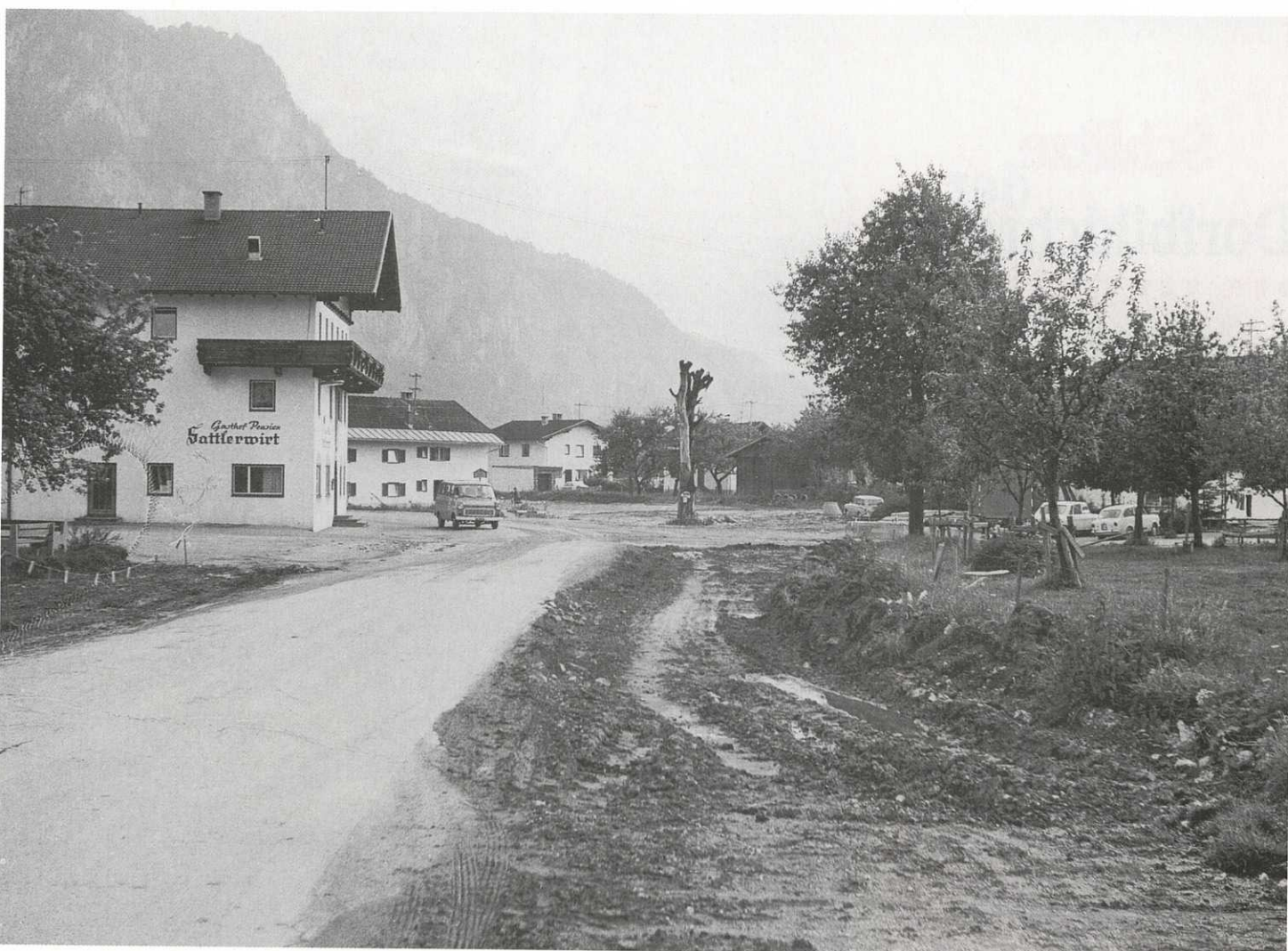
Oberndorf 1974 – Neutrassierung der Wildbichler- Bundesstraße.
