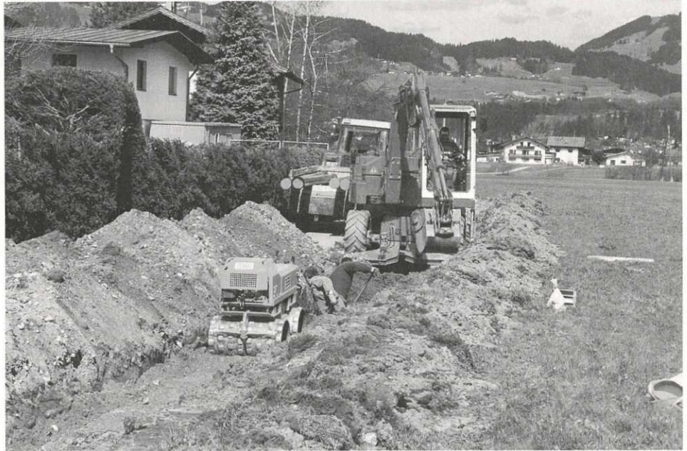
Von den Mitarbeitern des Bauhofes wird eine neue Wasserleitung verlegt.
