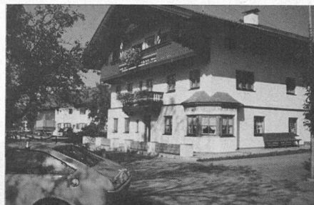
Auch der Riaphof im unteren Oberndorf erstrahlt seit diesem Jahr in neuem Glanz. Die Familien Astner/Thaler haben mit viel Fleiß und Geschick das Anwesen saniert.
