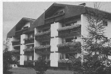
Roßbachweg: Schönste WE-Anlage Tirols (Teilansicht)
