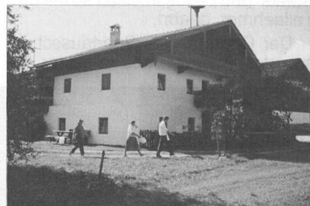
Eines der ältesten Oberndorf Häuser ist der Wimmerhof. Die Familie Jäger hat den Wohnteil nun sorgfältig renoviert und somit den Bestand dieses alten Objektes gesichert.
