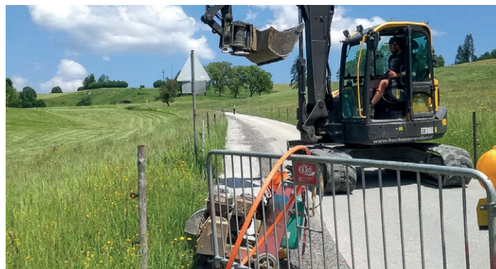
Der Breitbandausbau erforderte umfangreiche Arbeiten im gesamten Ortsgebiet.
