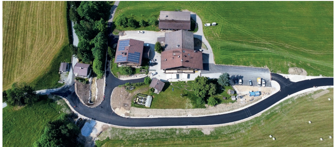
Im Bild ist deutlich erkennbar, dass die Straße auf Grund des bestehenden Geländes im Einschnitt geführt wird. Beidseitig neben den Banketten werden Sickermulden zur Straßenentwässerung ausgebildet (Fotonachweis: Harald Ganster).
