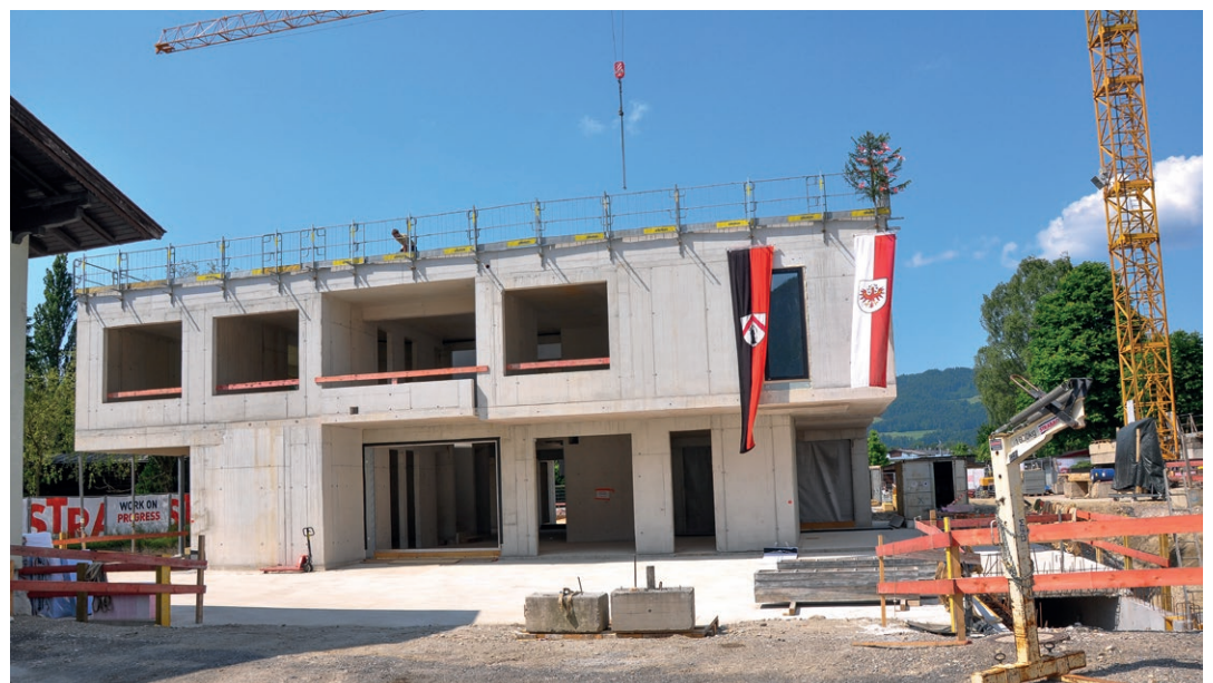
Rohbau von der Kaiserbergstraße aus gesehen, Blick Richtung Norden.
