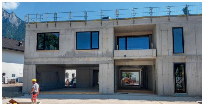
Der Rohbau des neuen Gemeindehauses steht. Blick vom neuen Kindergarten Richtung Süden.
