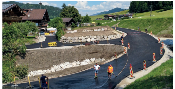
Im Bild ist deutlich erkennbar, dass die Straße auf Grund des bestehenden Geländes im Einschnitt geführt wird. Beidseitig neben den Banketten werden Sickermulden zur Straßenentwässerung ausgebildet (Fotonachweis: Harald Ganster).
