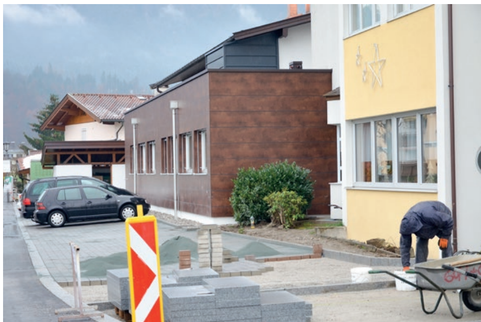
Die neu gestalteten Parkplätze vor dem Küchenanbau beim Altenwohnheim in Ebbs.
