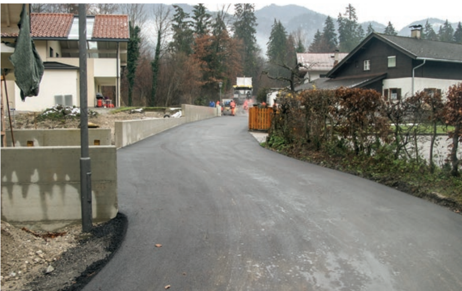
Im Zuge der Straßensanierung in Waldeck wurden die baulichen Maßnahmen für die Errichtung einer Straßenbeleuchtung auf der Verbindungsstraße entlang der Autobahn zwischen Waldeck und Eichelwang getroffen.
