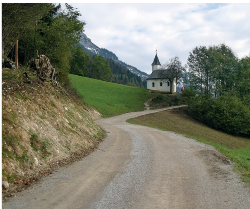
Der sanierte Kaisertalweg bei der Antoniuskapelle.
