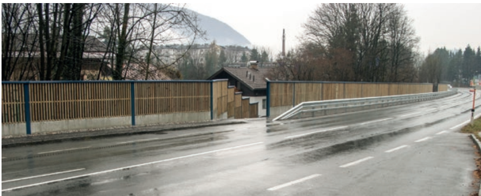
Die Lärmschutzwand für den Ortsteil Kaiserbach.
