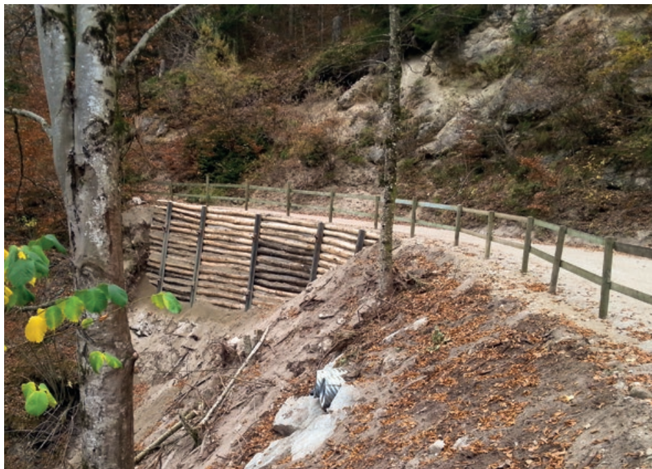
Aufgrund eines Hochwetterereignisses mussten Hangsicherungsarbeiten vorgenommen werden.
