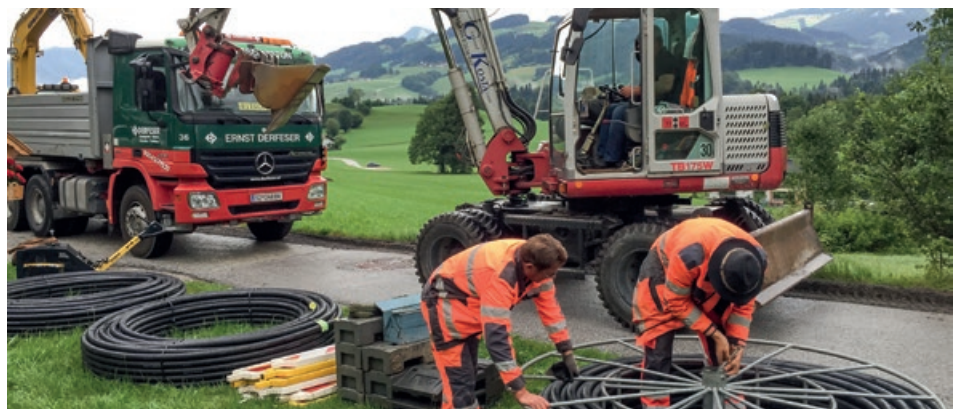
Neben Oberndorf wurde auch am Buchberg (Ortsteil Asching) mit dem Aufbau eines ultraschnellen Internetnetzes begonnen.
