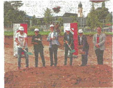
Die voraussichtliche Bauzeit soll bis August 2024 laufen. Foto: Nimpf
