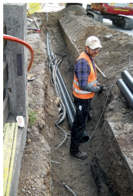
Die Baufirma Kofler bei der Verlegung von LWL-Rohren am Kaiseraufstieg.
