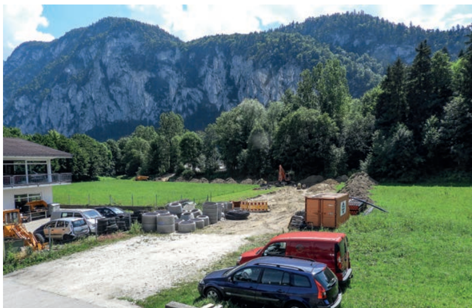
Grabungsarbeiten Kanal- und Wasseranschluss für das Gewerbegebiet Fürhölzl.
