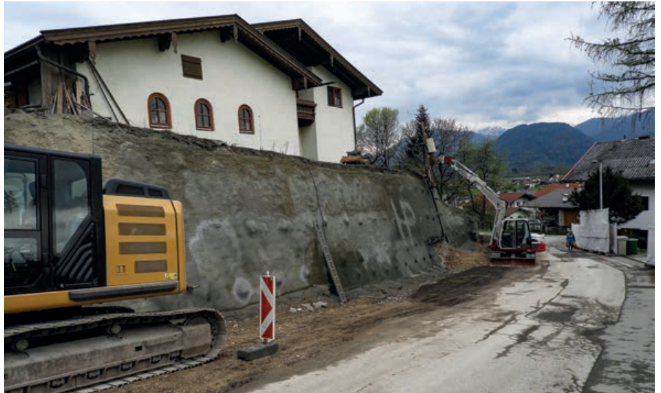
Umfangreiche Hangsicherungen im Bereich des Lobacher Bühels.
