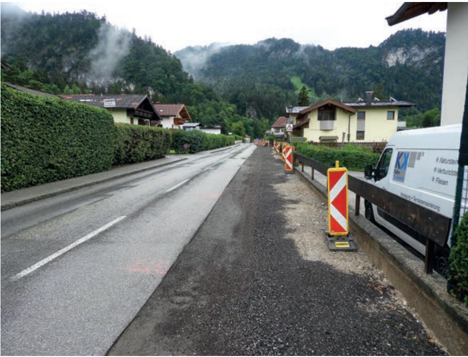
Grabungsarbeiten der Stadtwerke Kufstein im Bereich Kaiseraufstieg.
