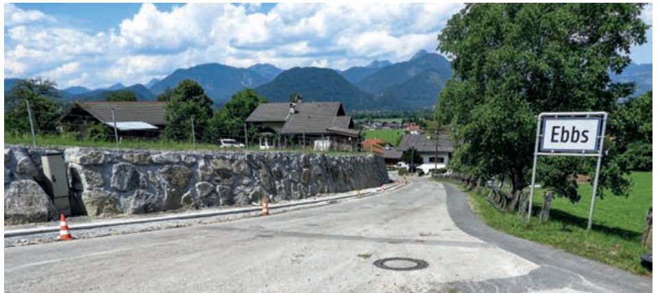
Umfangreiche Hangsicherungen im Bereich des Lobacher Bühels.
