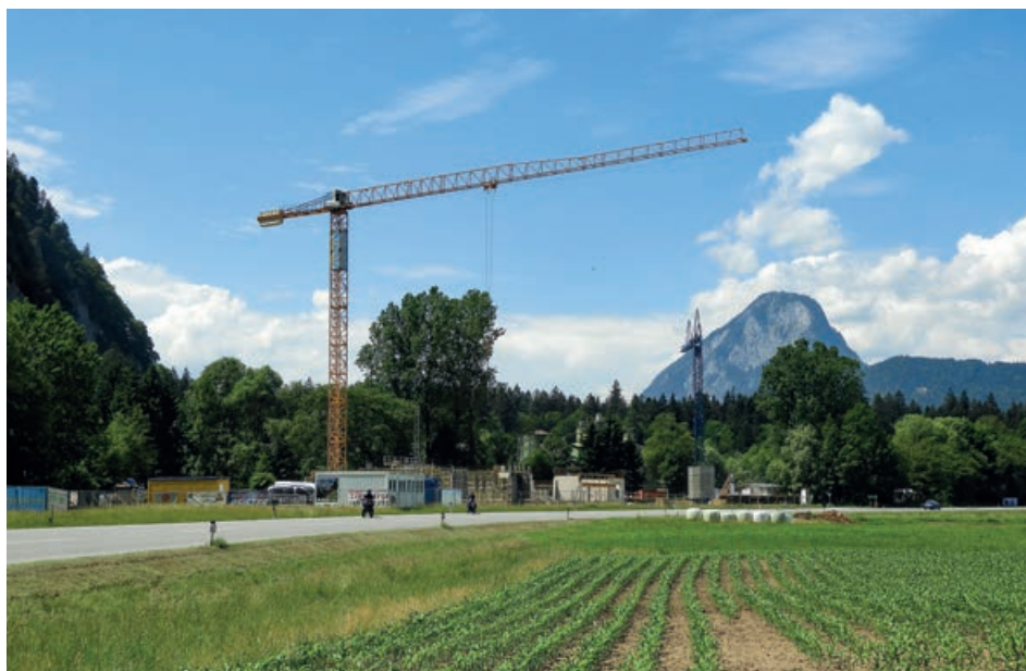
Das im Bau befindliche Betriebs- und Handelsgebäude Kaiser Nordwand.
