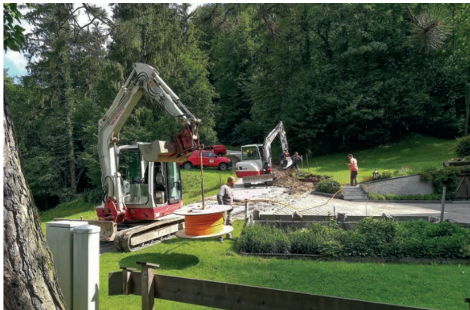
Ausbau des Breitbandnetzes Richtung Buchberg im Bereich St. Nikolausweg.
