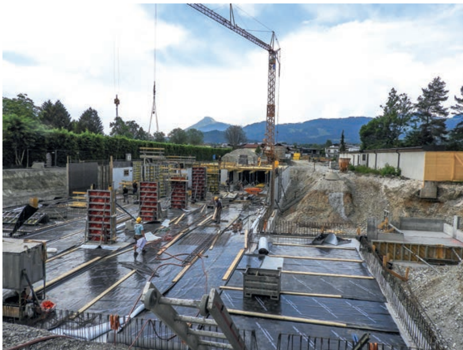
Bei der Großbaustelle Kindergarten konnte im Mai die Bodenplatte betoniert werden.
