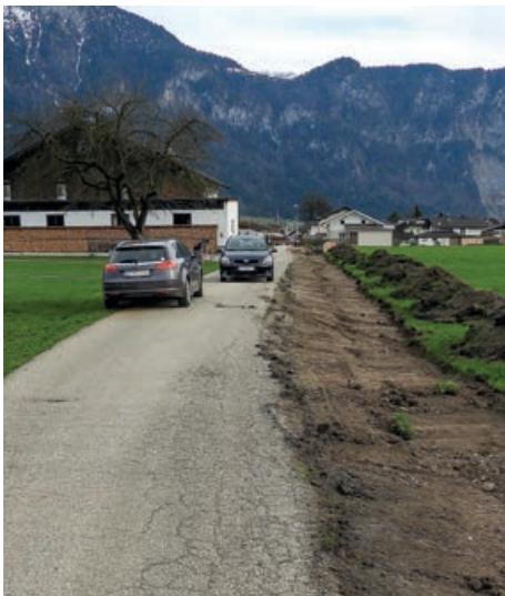
Die Gemeindestraße Weidach vor der Sanierung sowie ...
