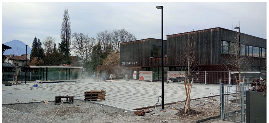
Der neue Marktplatz wurde mittlerweile fertiggestellt.
