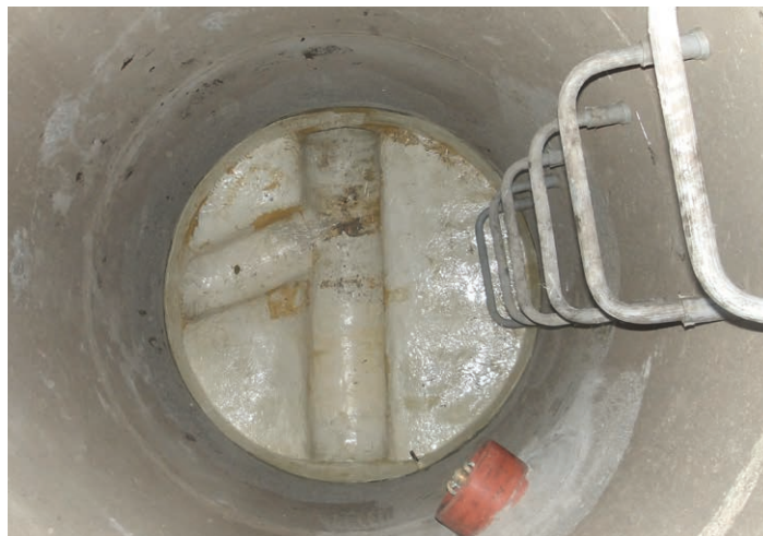
Der Schacht nach der Sanierung in Kombination von Handlaminat und Mörtel.
