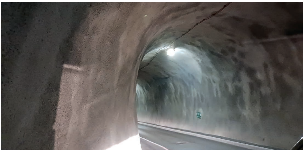
Vor kurzem wurden die vorhandenen Leuchtstoffröhren im Kaisertaltunnel durch stromsparende LED-Leuchten ausgetauscht.
