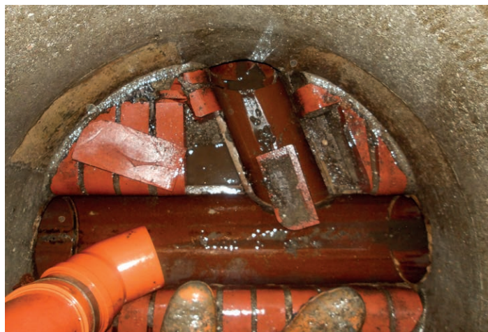
Der Schacht vor der Sanierung in Eichelwang.
