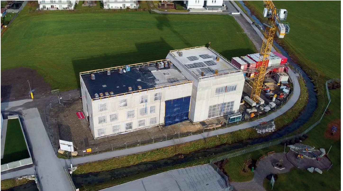
Nach der Rohbaufertigstellung (Ende des Jahres 2023) wurden von unserer örtlichen Bauaufsicht Drohnenaufnahmen des Gebäudes erstellt. Im unteren Bildbereich sind der Ebbsbach und der Spielpark samt Kindergartenparkplatz erkennbar (Fotonachweis: Michael Jahns, AEP).
