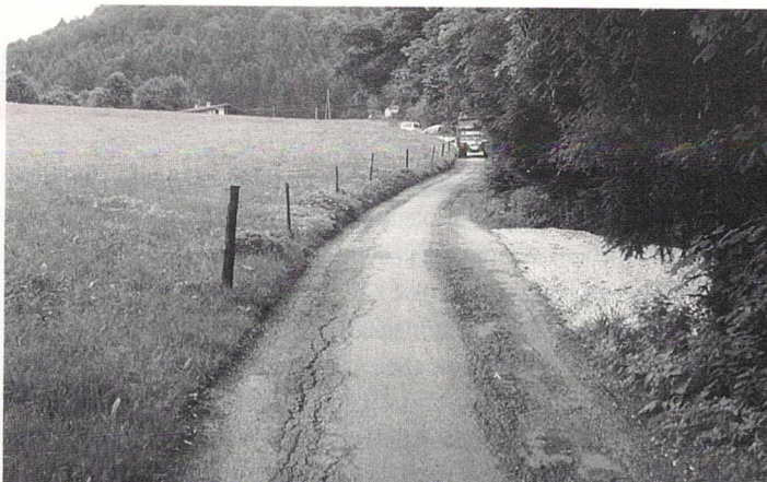
Sanierung des Gemeindegeweges bei Reisch, einige Ausweichen erleichtern bei gleicher Wegbreite die Flüssigkeit des Verkehrs.
