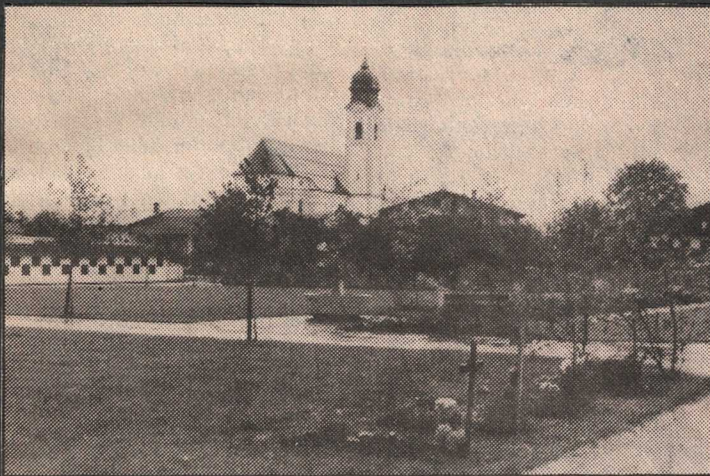
Detailansicht gegen Pfarrkirche.
