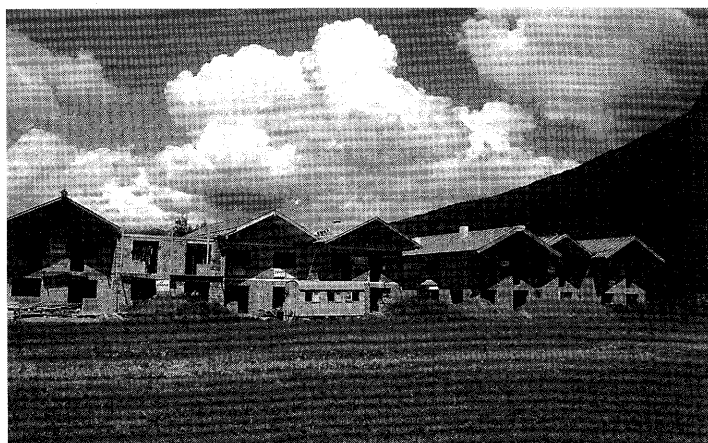
Baubeginn im Wohnpark Oberndorf
