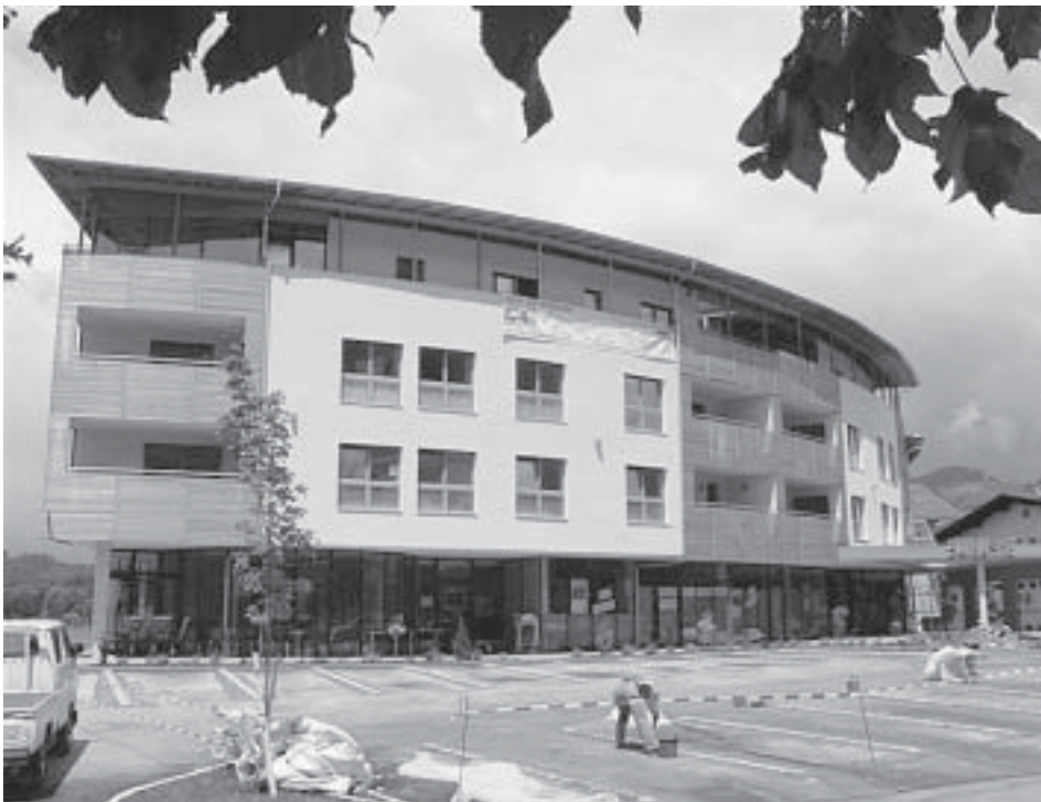
Das gelungene Wohn- und Geschäftsgebäude der Firma Bodner Bau schließt den Ortskern.
