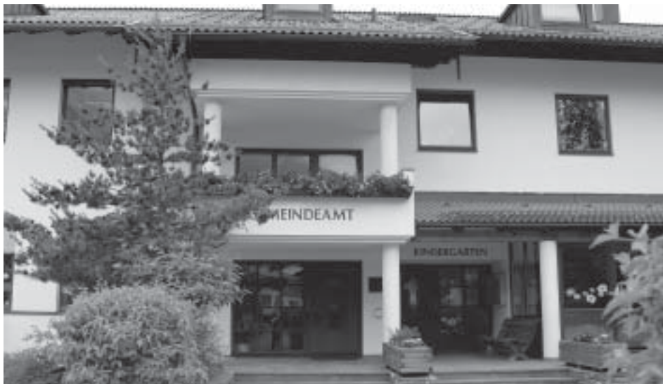
Das Gemeindehaus aus dem Jahre 1911 wird saniert und erhält einen Lift.
