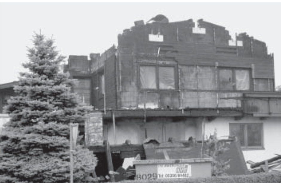
Zwischenzeitlich wurde mit dem Wiederaufbau der Brandruine begonnen.
