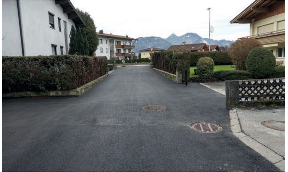
Erneuerung der Asphaltdecke in Oberndorf.
