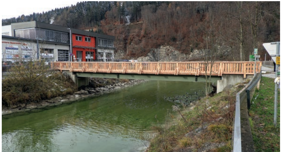
Sanierung Geh- und Radwegbrücke über den Kaiserbach beim Einkehrplatzl.
