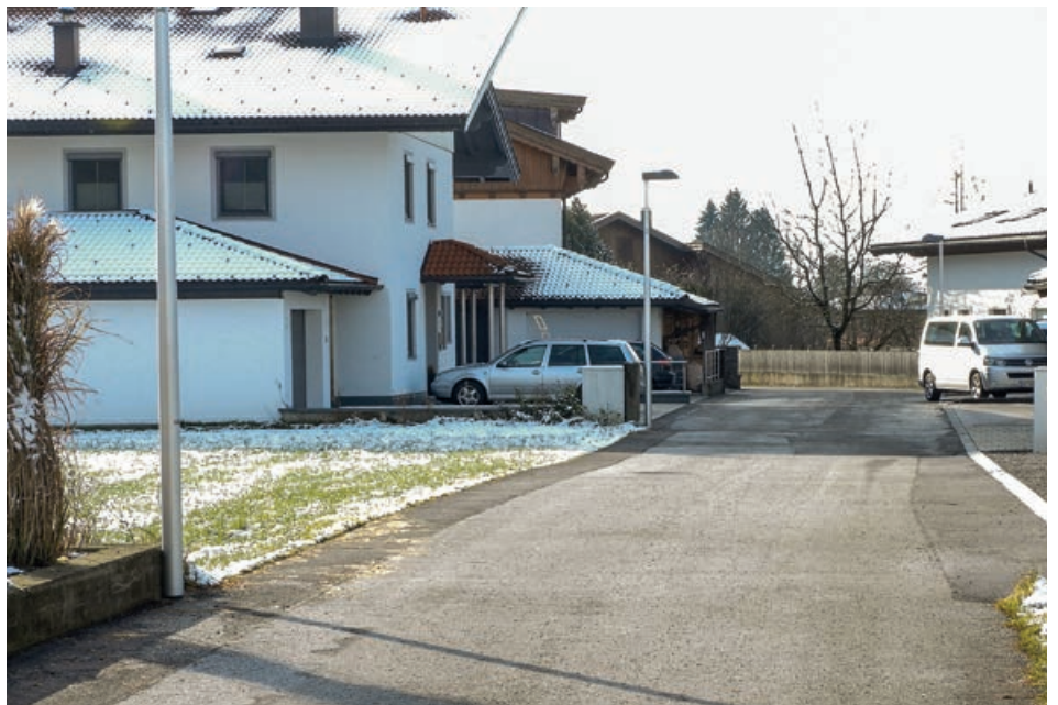
Straßenbeleuchtung beim Oberhamweg.
