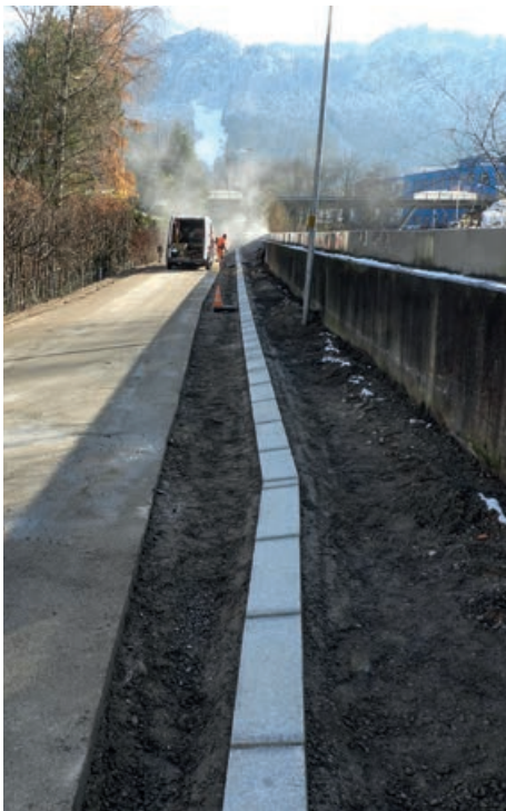
Neuer Gehsteig in Waldeck entlang des Kaiserbaches.
