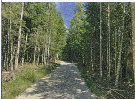
Der 350 Meter lange Haselbodenweg im hinteren Kaisertal wurde 2018 als Sackgasse mit vier Metern Breite gebaut. Am Ende des Weges befindet sich ein breiter Umkehrplatz, damit Maschinen und Lkw wenden können. Erreichbar ist der Weg bislang jedoch nur durch wesentlich schmalere Wege.
