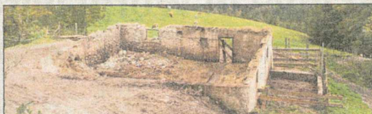
Die Hechleitalm nach den Abrucharbeiten. Rechts die gefüllte Güllegrube. Foto: Josef Wagner
