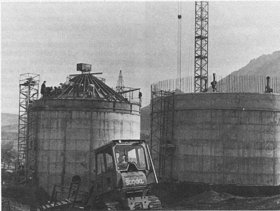
Bau der Faultürme
