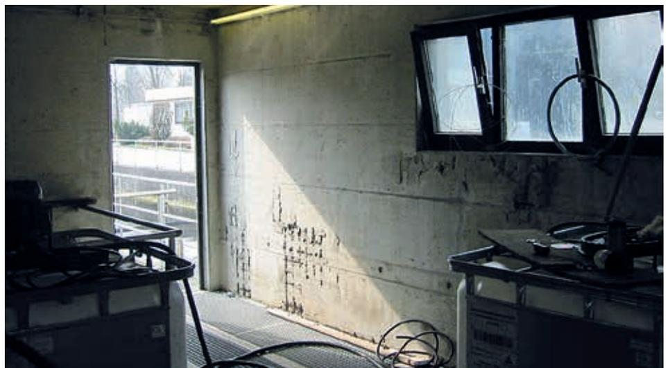
Nach 25 Jahren Betrieb sind auch Sanierungen am Bestand erforderlich. Beispielhaft sind hier Betonschäden im Überschussschlammgebäude zu erwähnen.
