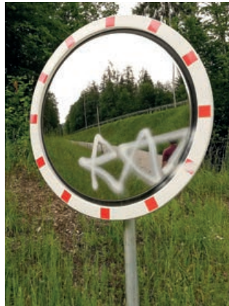
Der beschmierte Verkehrsspiegel auf der rechten Seite der Unterführung in Eichelwang.
