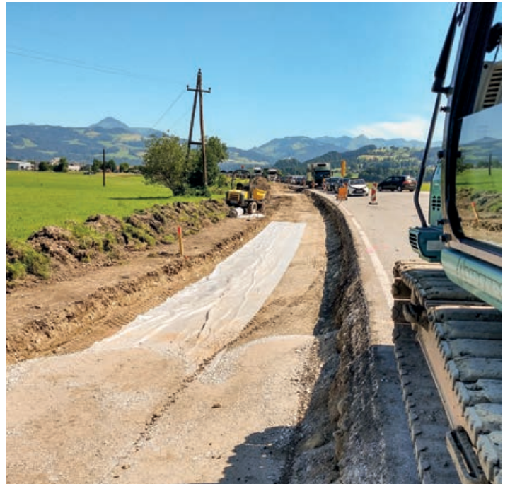
Die Baustelle Richtung Ebbs.
