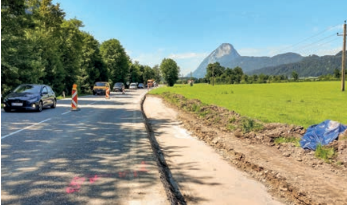
Die Bauarbeiten Richtung Kufstein.
