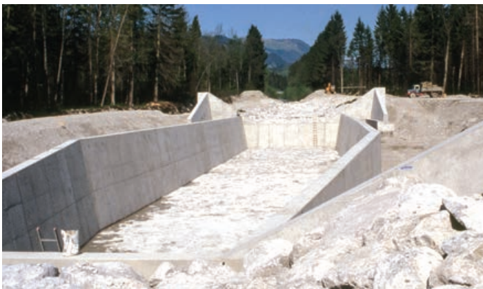
Der neu errichtete Schotterfang am Jennbach. (Fotonachweis: OSR Georg Anker)
