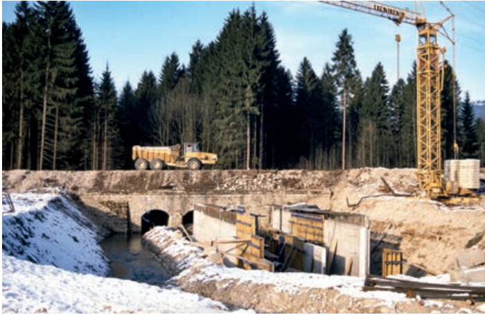
Altes und neues „Millionenloch“, Flussunterführung der „Ebbsn“ unter den Jennbach. (Fotonachweis: OSR Georg Anker)
