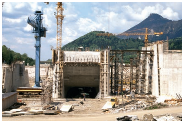
Baustelle Wehranlage beim Innkraftwerk. (Fotonachweis: OSR Georg Anker)
