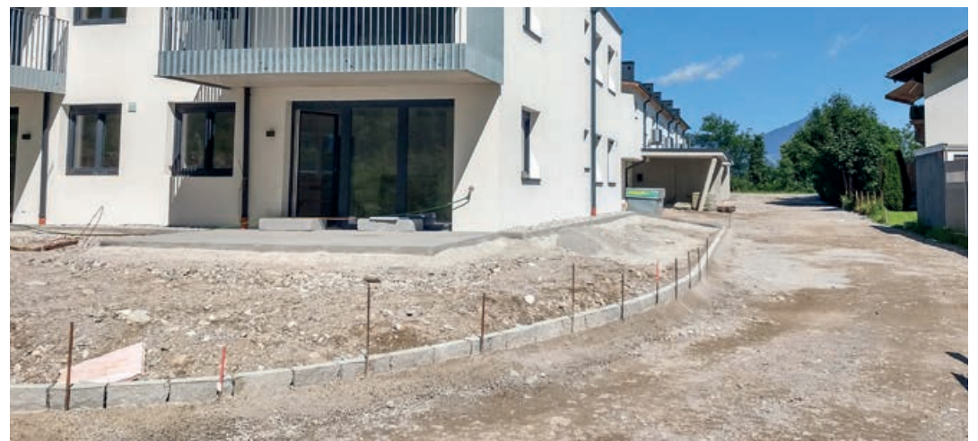
Die Randsteinarbeiten konnten bereits abgeschlossen werden.
