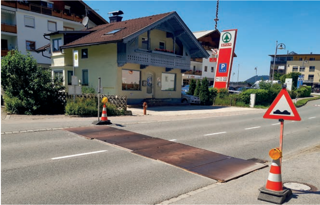
Im Bereich der Wildbichler Straße B175 wurden die schadhaften Bereiche mit Stahlplatten überdeckt.
